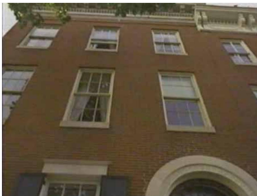
Figura 7 - Fachada da casa da família Sloper
