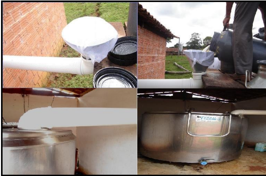
Quadro 3. Figuras da tubulação de PVC utilizada para auxiliar o transvase de leite no tanque de expansão comunitário 2.
