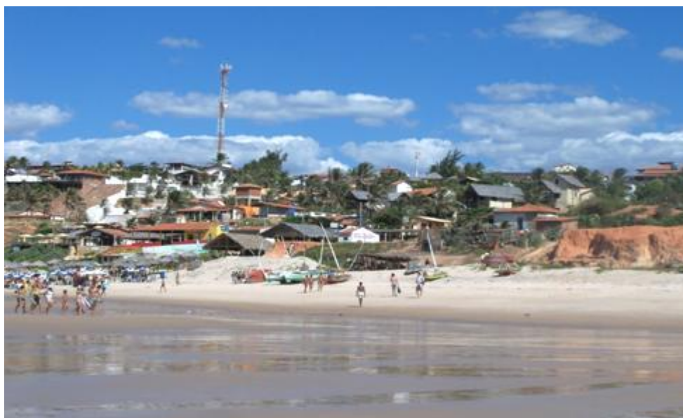
Fotografia 46 - Visão panorâmica de Canoa Quebrada com destaque para a intensa ocupação e destruição da falésia Fonte: Silva, 2012.
