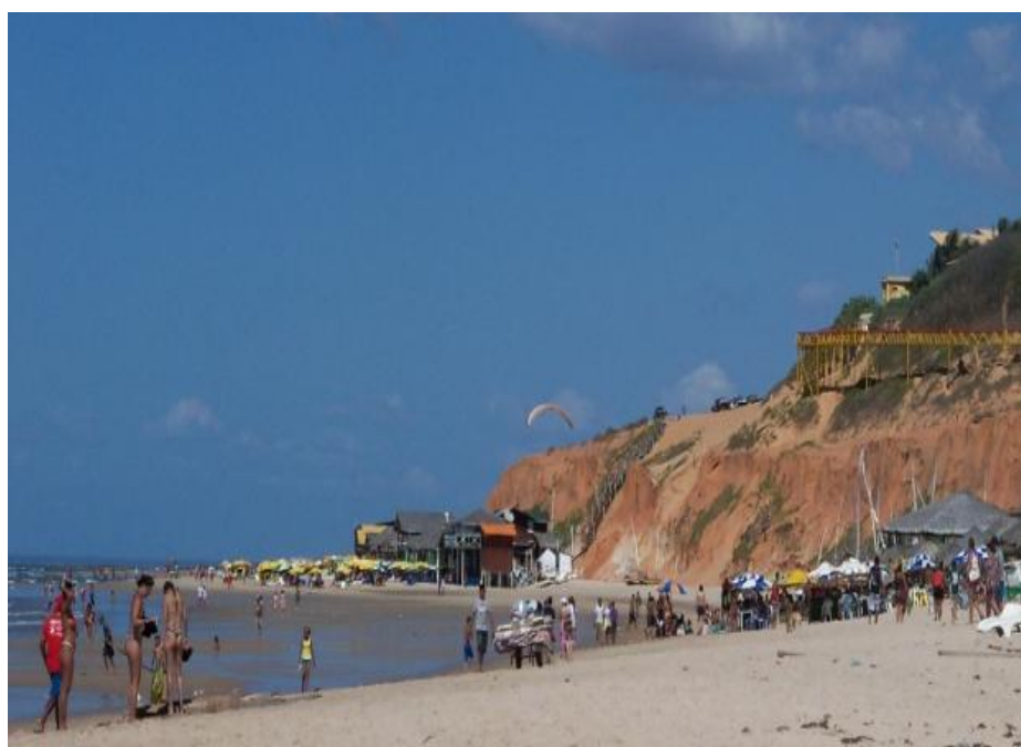
Fotografia 17 - Construção no topo e no sopé da falésia Fonte: Silva, 2012.
