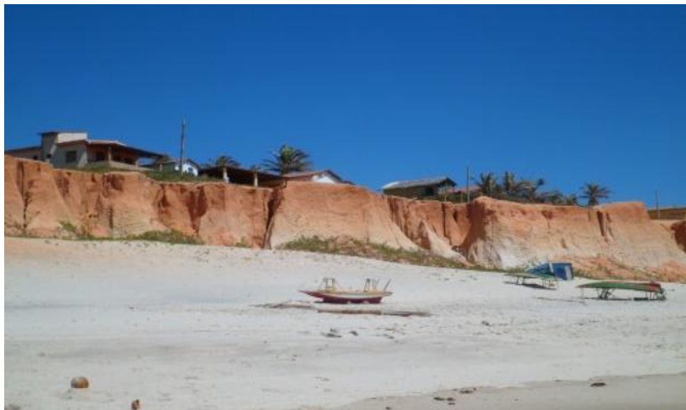
Fotografia 16 - Construção sobre as falésias. Fonte: Silva, 2012.
