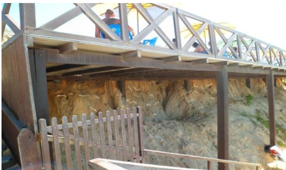
Fotografia 15 - Construção no sopé da falésia.
