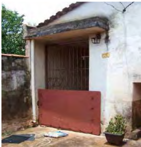
Figura 34. Sistemas de eclusas utilizados pelos moradores da Vila Virgínia para conter as inundações (Foto do autor, 10/01/2006).
