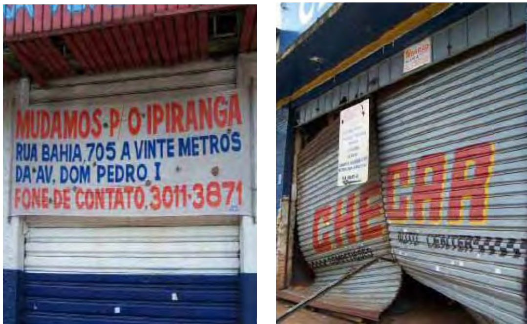
Figura 46. Estabelecimentos comerciais abandonados na avenida Francisco Junqueira (Foto do autor, 10/01/2006).
