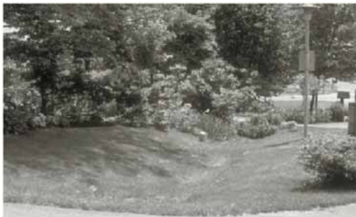
Figura 23: bacia de detenção vegetada, associada a lote residencial. Fonte: Maryland (1999)
