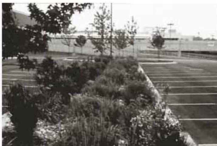
Figura 21: “biorretentores” em estacionamento. Fonte: Maryland (1999)
