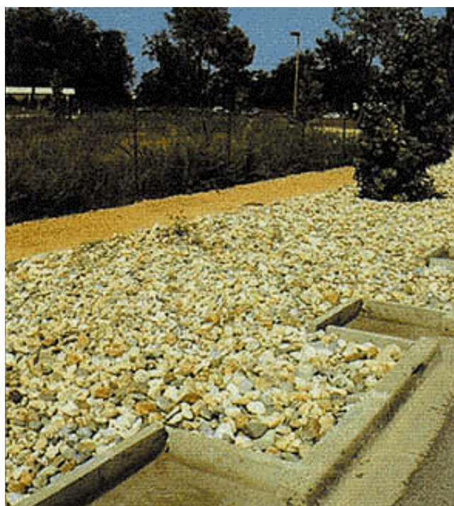
Figura 20: Trincheiras de infiltração com tratamento paisagístico Fonte: Galvão (2000)
