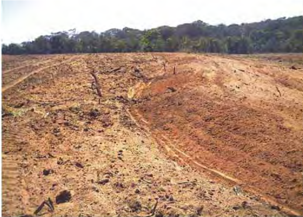
Foto 5 - Terraceamento sendo realizado em terreno arenoso para cultivo agrícola data: jun/2004 - autor: wmm
