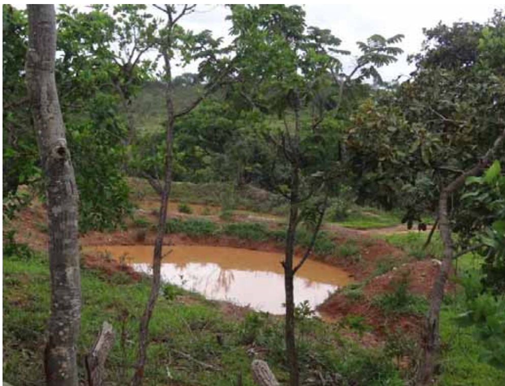
Figura 27: Barragem de contenção às margens da estrada vicinal no Planalto Rural Fonte: Pesquisa direta: Fonseca (2011)
