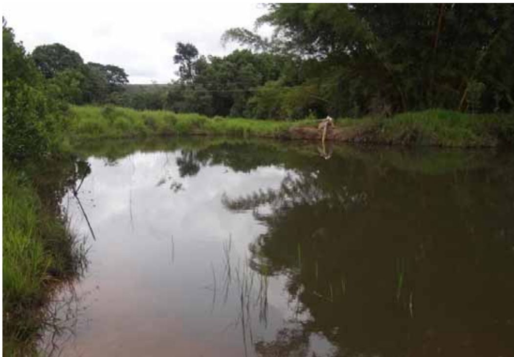
Figura 28: Barraginhas de armazenamento de água de chuva – Comunidade do Planalto Rural Fonte: Pesquisa direta: Fonseca (2011)
