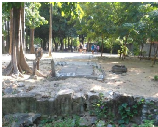
Figura 38 – Parque Parreão: parte da ponte existente
