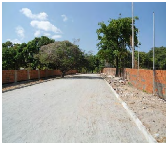
Figura 14 – Muro do empreendimento
