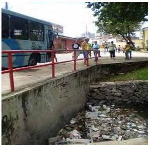
Figura 27 – Parque Pajeú/ Degradação ambiental
