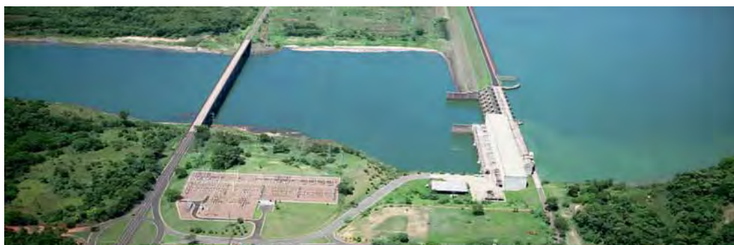
Figura 39. Usina Hidrelétrica Sérgio Motta
