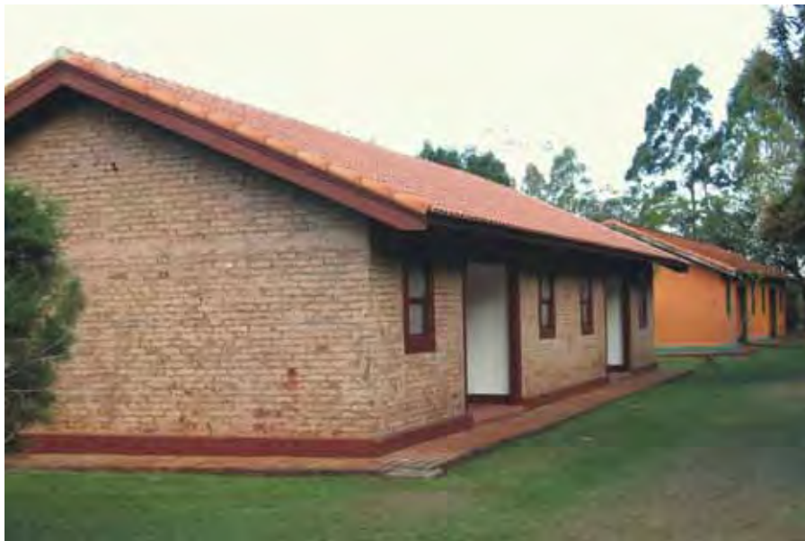
Figura 15 – Unidade habitacional, utilizando a antiga colônia.
