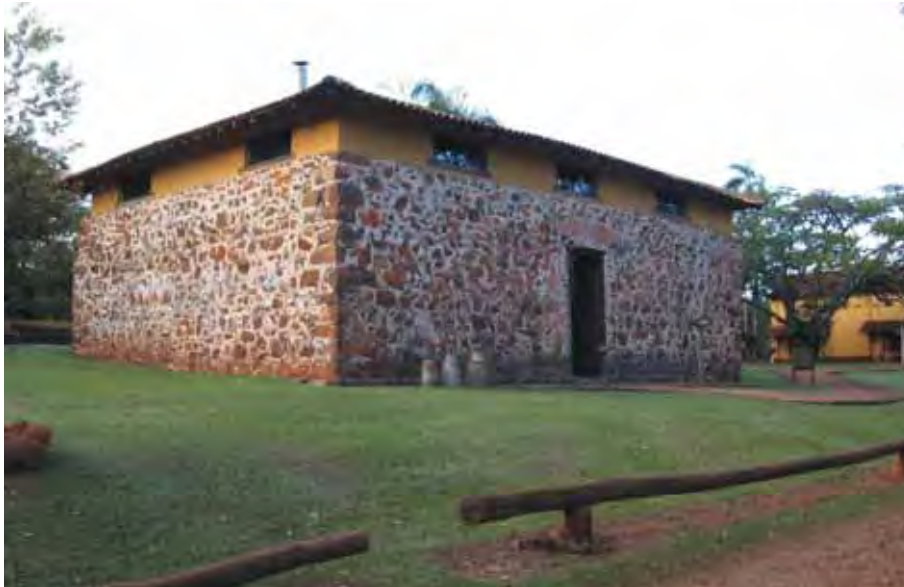
Figura 14 – Paiol de pedra.
