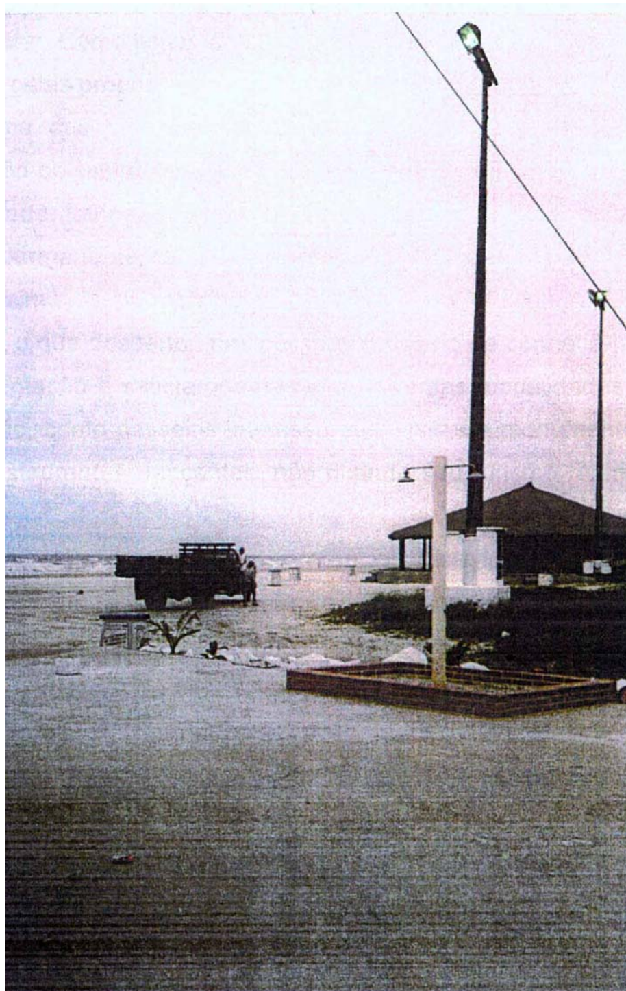
FOTO 18. Infra-Estrutura da Praia do Cibratel.
