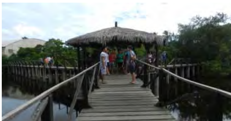
Fotografia 42 – Travessia Sobre Manguezal no Riacho São Luís.
