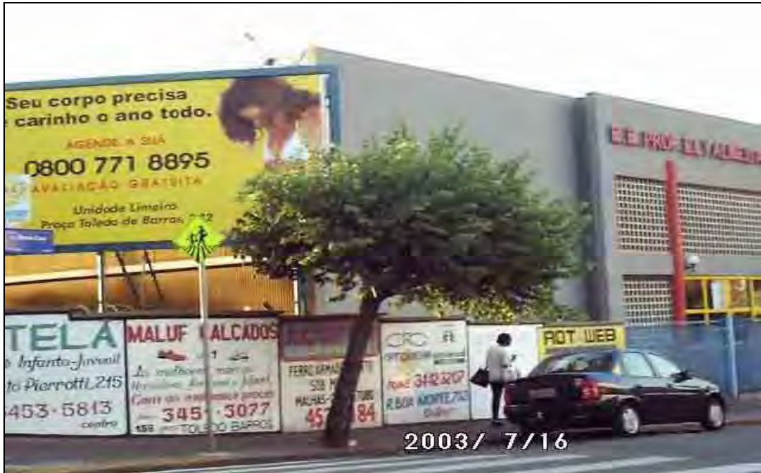
Figura 19 - Escola Estadual Ely de Almeida Campos: situação atual
