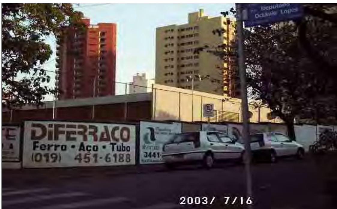
Figura 20 - Escola Estadual Ely de Almeida Campos: situação atual
