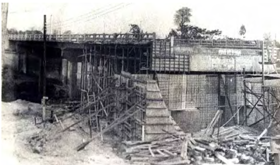
Figura 06 – Construção da Ponte de Alvenaria sobre o Rio Vermelho – Déc. 1950
