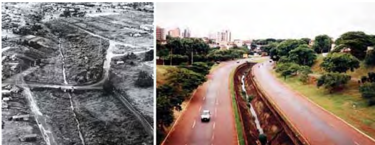
Figura 47 – Córrego das Pombas antes das obras de canalização (Década de 70); Via Expressa (2002).
