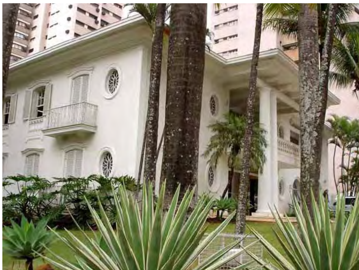
Figura 46 – Residência de Otávio Pedriali (1970/76), atual Itaú Personalité, Rua Piauí com Avenida Higienópolis.
