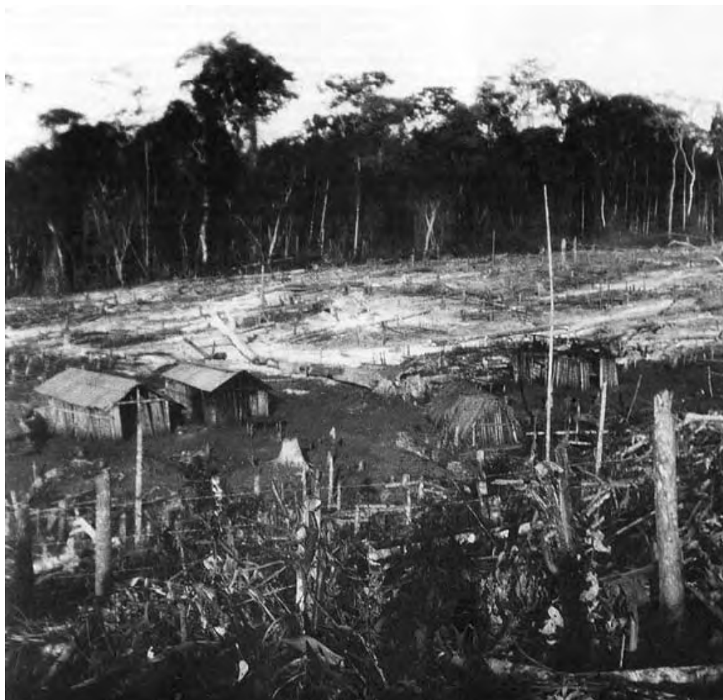
Figura 51 – Primeira derrubada de 10 alqueires pela CTNP e os primeiros ranchos de palmito no Patrimônio Três Bocas.
