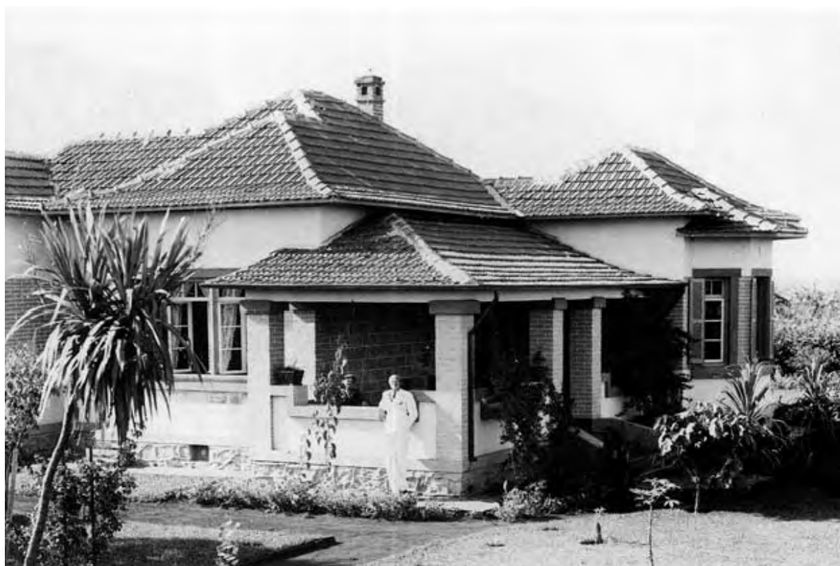
Figura 34 – Primeira Residência em Alvenaria na Avenida Higienópolis, Propriedade de Victor Larionoff (1936)
