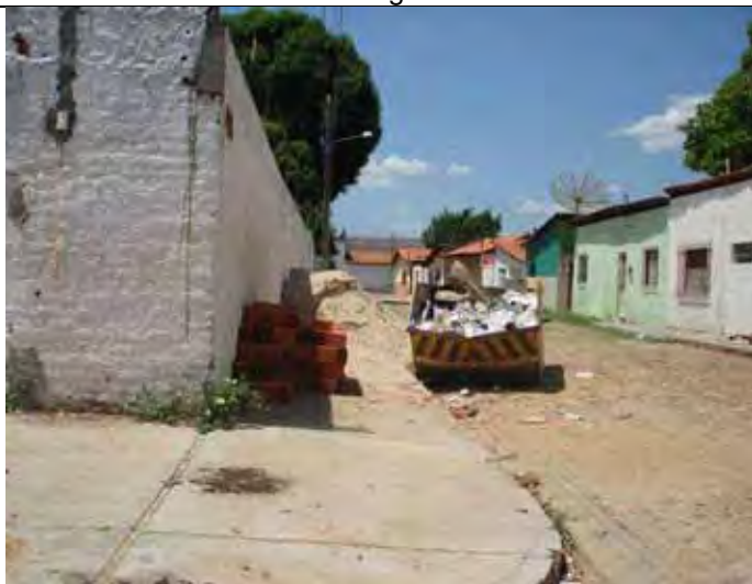
FIGURA 26e. Disposição adequada de resíduos de construção civil.
