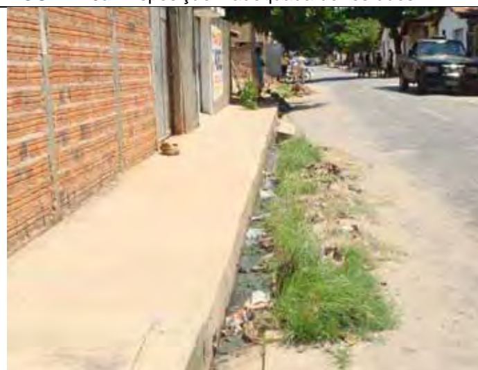
FIGURA 10c. Estrutura de saneamento
