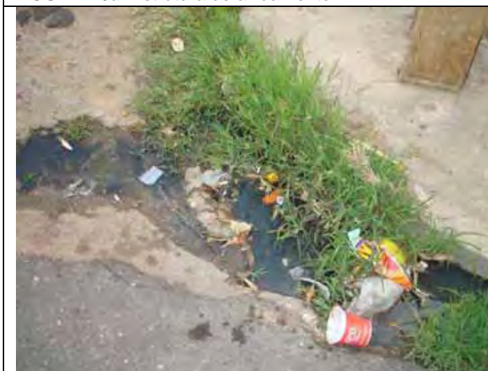
FIGURA 16c. Estrutura de saneamento
