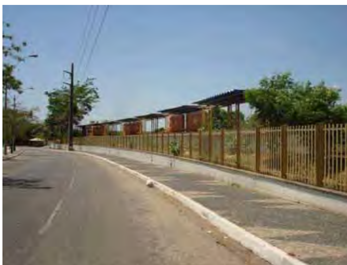
FIGURA 18. Estação do metrô, localizada no bairro Matinha. Fonte: CUNHA, 2008.
