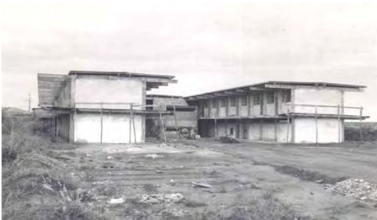
Figura 18: Construção do Prédio do Campus da UNESP de Marília Fonte: CGB – Coordenadoria Geral de Bibliotecas – Marília
