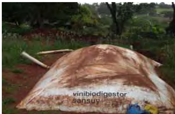
FIGURA 8 – Biodigestor operando, a parte inflável corresponde ao gasômetro aonde acumula-se o biogás gerado no processo.
