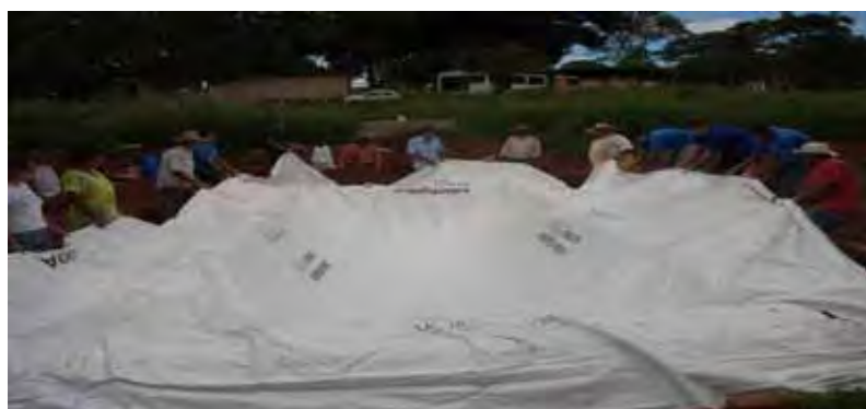
FIGURA 7 – Instalação da lona de PVC flexível com as duas partes reator do biodigestor e gasômetro vulcanizadas transformando-se em uma peça única
