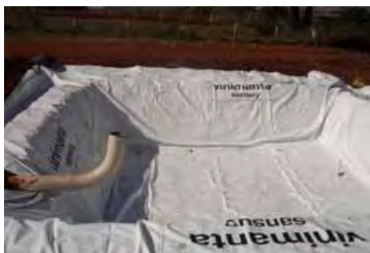
FIGURA 9 – Instalação da lagoa de armazenamento de biofertilizante.
