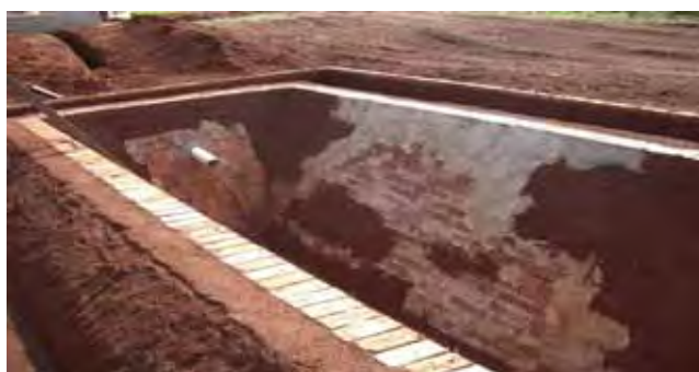
FIGURA 6 – Escavação concluída e dimensionamento do biodigestor segundo planta na etapa anterior a colocação da lona
