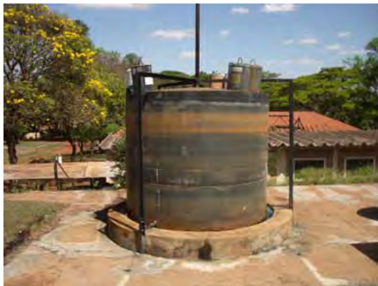
FIGURA 1 – Biodigestor modelo indiano instalado no departamento de Engenharia Rural FCAV-UNESP, campus Jaboticabal.
