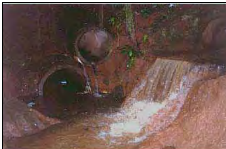
Figura 192: Galerias instaladas no interior do Parque do Ingá. Foto: BOVO, M. C. 2006.
