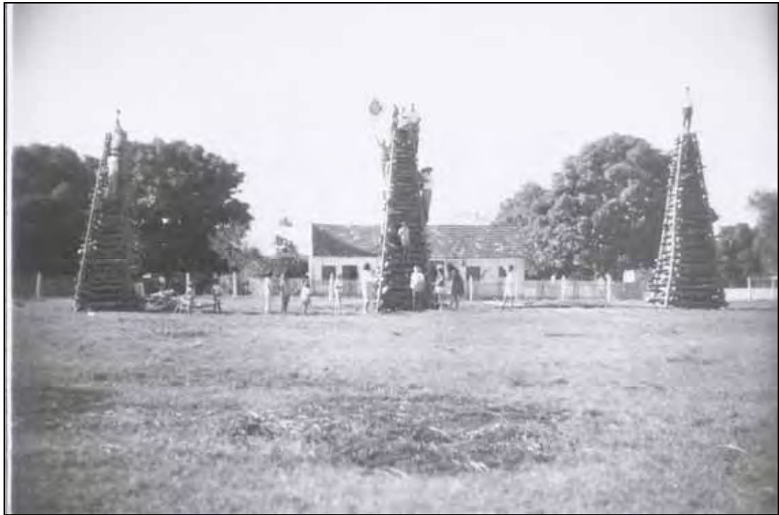
FIGURA 4.5 Área central de Bonito na década de 1950 – Local da praça central
