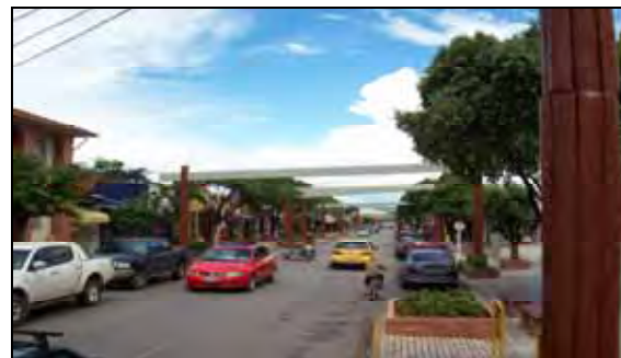
FIGURA 4.23 Parte da avenida Cel. Pilad Rebue já revitalizada Fonte: Acervo do próprio autor. (2009)
