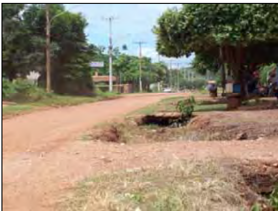
FIGURA 4.20 Rua da cidade de Bonito – Falta galeria de águas fluviais, pavimentação, guias de sarjeta e calçadas Fonte: Acervo do próprio autor. (2009)
