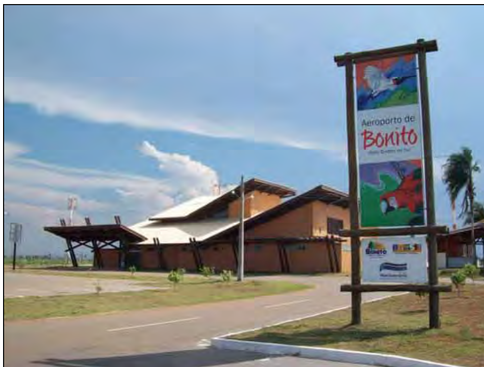
FIGURA 4.17 Vista da recepção do Aeroporto Internacional de Bonito Fonte: Acervo do próprio autor. (2009)
