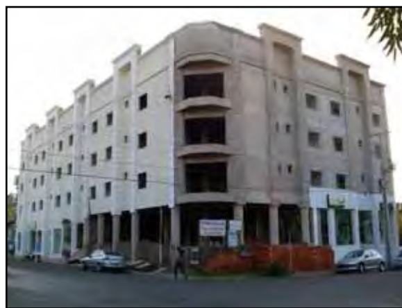
Figura 106: Futuras Instalações do “Francisco Beltrão Palace Hotel” em fevereiro de 2009.
