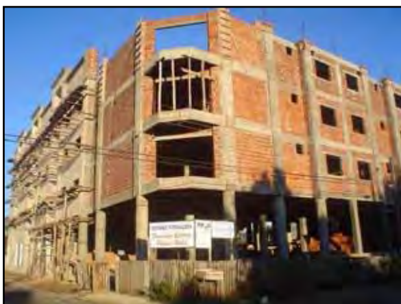
Figura 105: Futuras Instalações do “Francisco Beltrão Palace Hotel” em julho de 2008.
