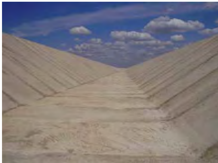
Figura 2: Canal de concreto da Transposição do rio São Francisco.
