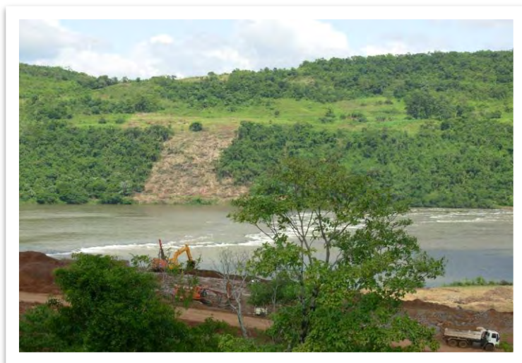
Foto 7 - Área onde está sendo construída a hidrelétrica Foz do Chapecó
