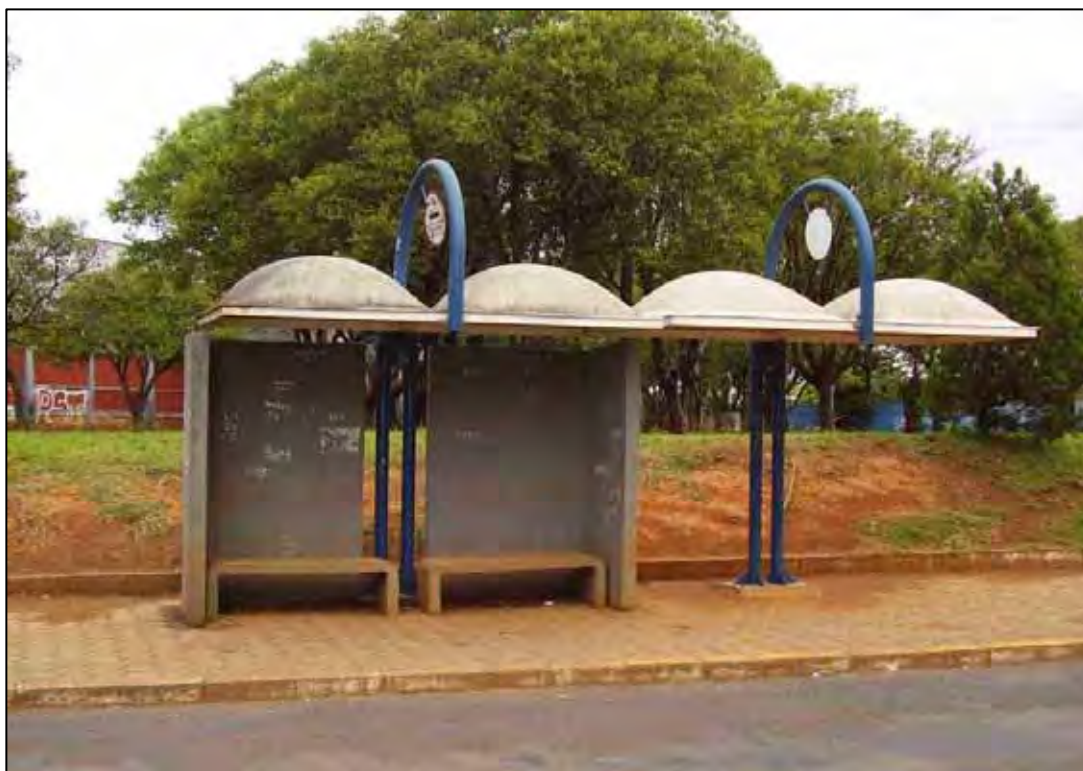
Foto 54 - TRANSPORTE COLETIVO: TIPOS DE PONTOS DE ÔNIBUS (Avenida Prefeito Moacir Julio Silvestre - Bairro Dos Estados) Fonte: Foto do autor (2007)
