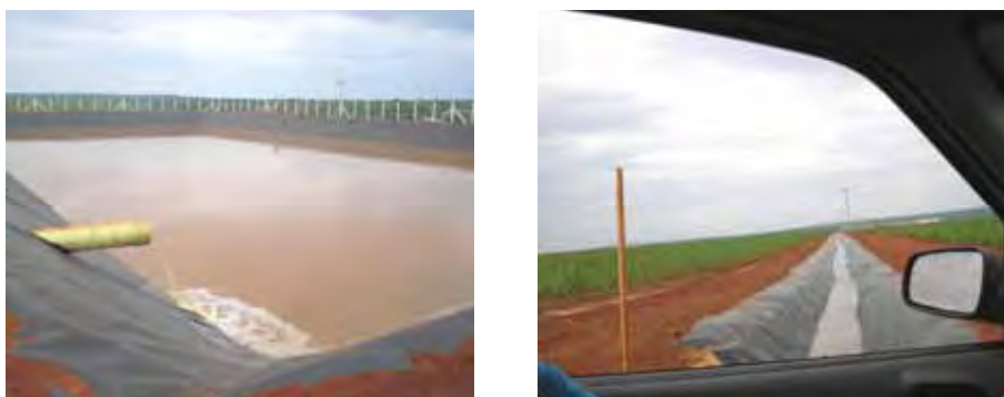
Foto 22 - Reservatório de vinhaça - Foto 23 - Canal de escoamento de vinhaça
