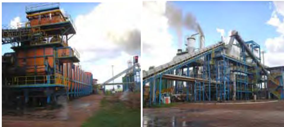
Foto 15- Difusor para moagem - Foto 16 - Caldeira automatizada
