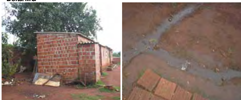
Fotos 36 e 37 - Cômodos de alvenaria e esgoto a céu aberto – Delta/MG
