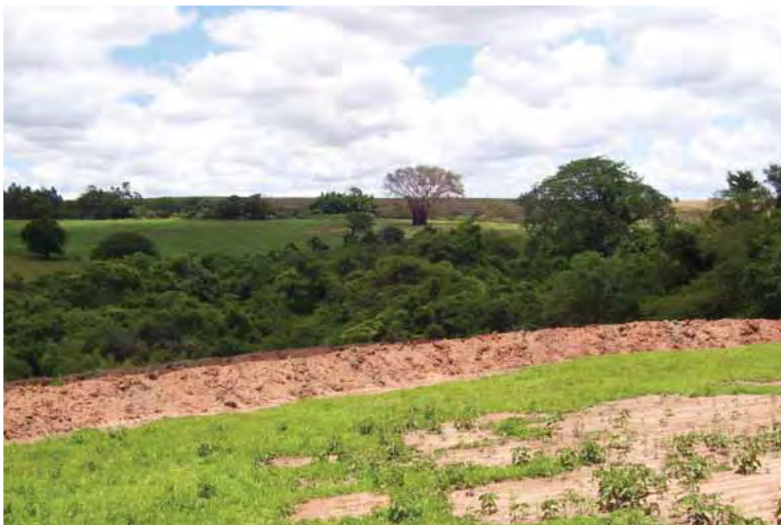
Figura 18: Terraceamento realizado com recursos do PEMH no município de Dracena
