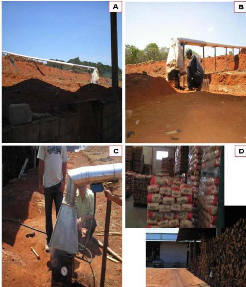
Figura 2. Processo tecnificado para obtenção de carvão vegetal e extrato pirolenhoso (EP) de qualidade. A: Forno de encosta e tubulação para processo de condensação da fumaça (36 m); B: Controle da temperatura na saída da primeira chaminé do forno e captação da fumaça; C: Coleta do EP (bruto) e D: Carvão vegetal pronto para uso. Fonte: Fernando Sá (Adaptado por SILVEIRA, 2010).
