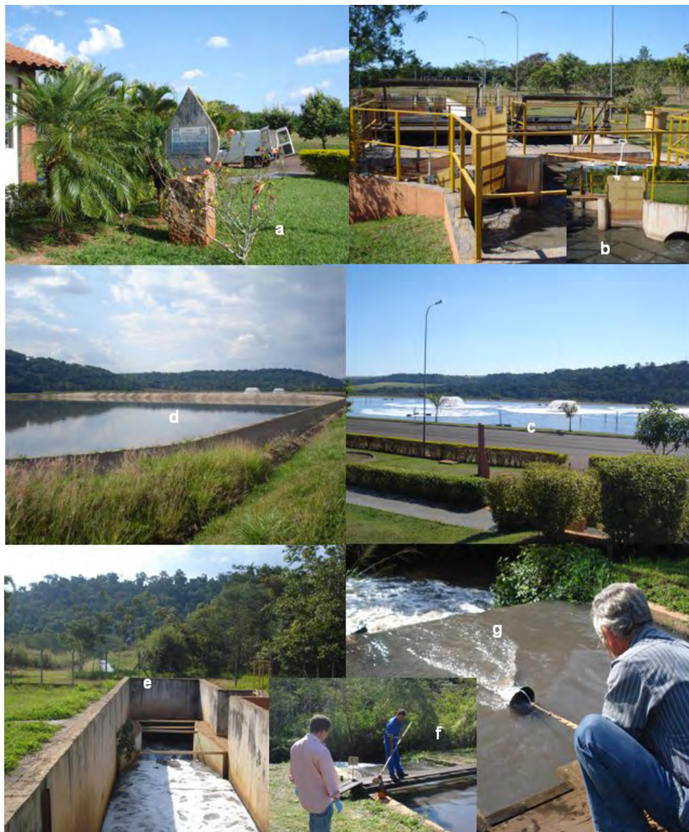
Figura 12 - Fotos da ETE Araraquara. a) Sede da ETE; b) Chegada do esgoto – sistema de gradeamento e medição de vazão; c) Lagoas aeradas; d) lagoas de sedimentação; e) Calha de saída do esgoto tratado; f - g) ponto de coleta do esgoto tratado chegando ao rio.
