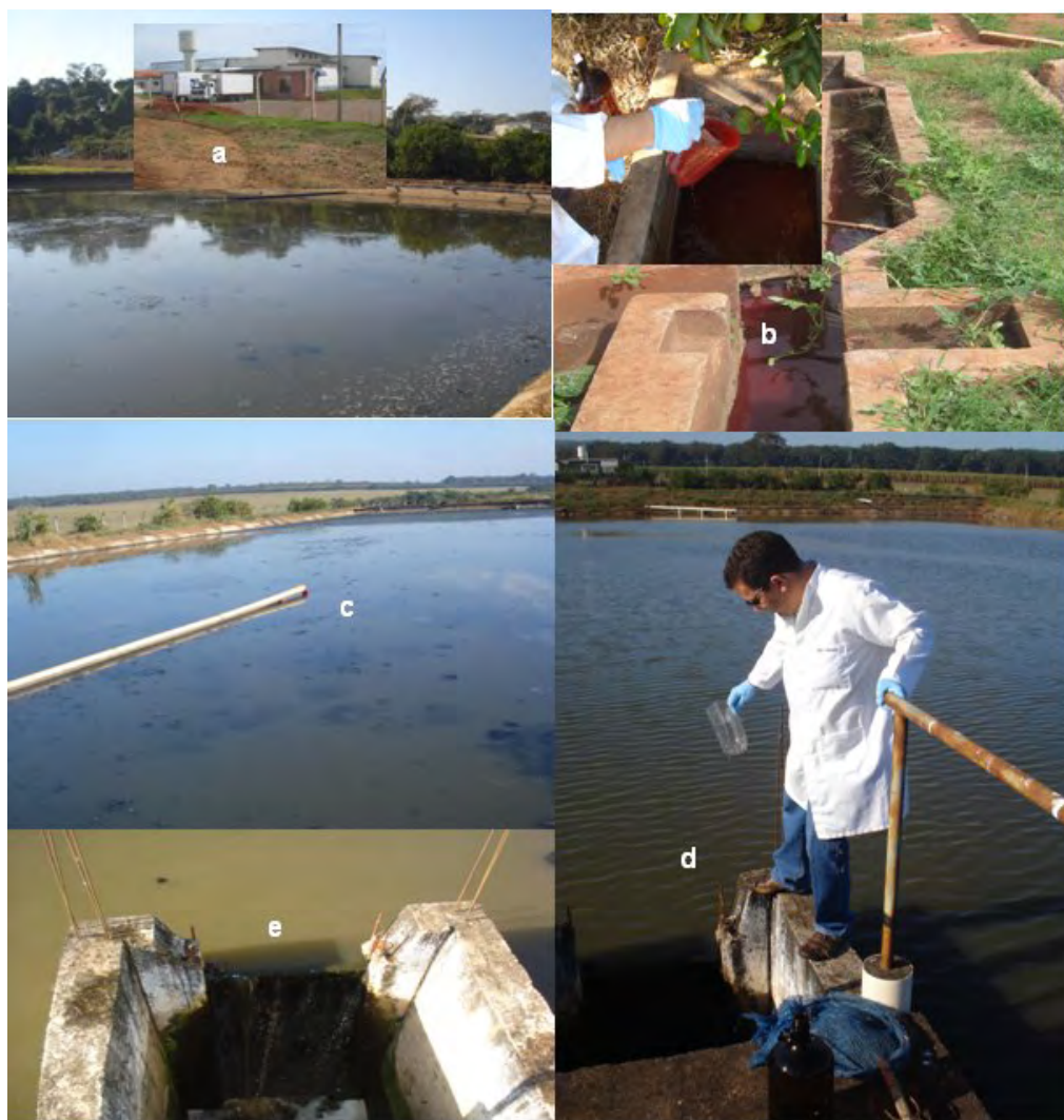
Figura 28 – Fotos da ETE de Trabiju. a) Frigorífico situado na parte da frente da ETE; b - c) Aspectos - cor do esgoto bruto; d - e) Ponto de coleta do esgoto tratado.
