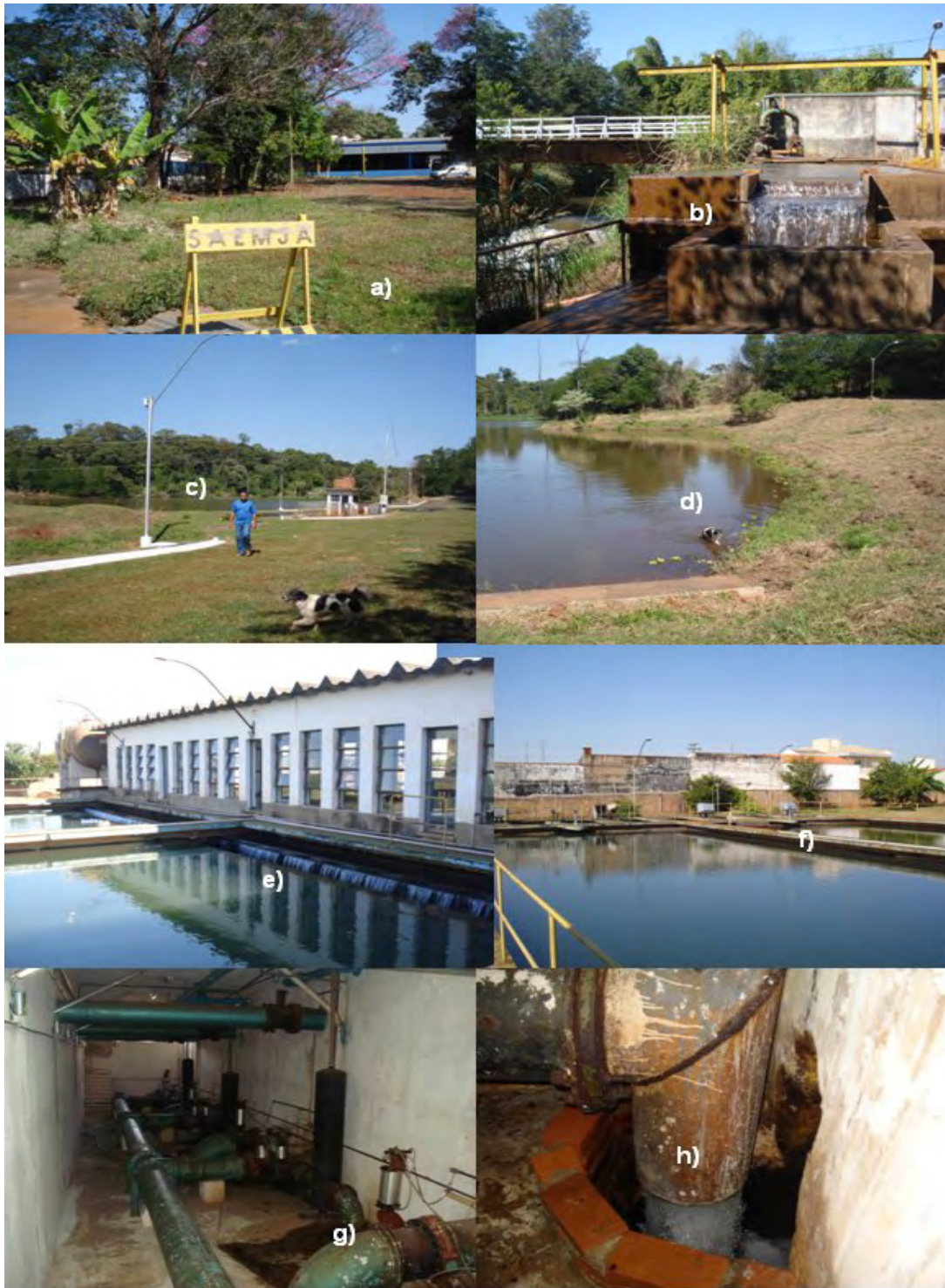
Figura 23 – ETA Jaú - Fotos g – h) Os principais pontos de captação para o abastecimento da cidade são provenientes da represa Amadeu Botelho – fotos a – b), próximo ao rio Jaú e represa São Joaquim, fotos c – d).
