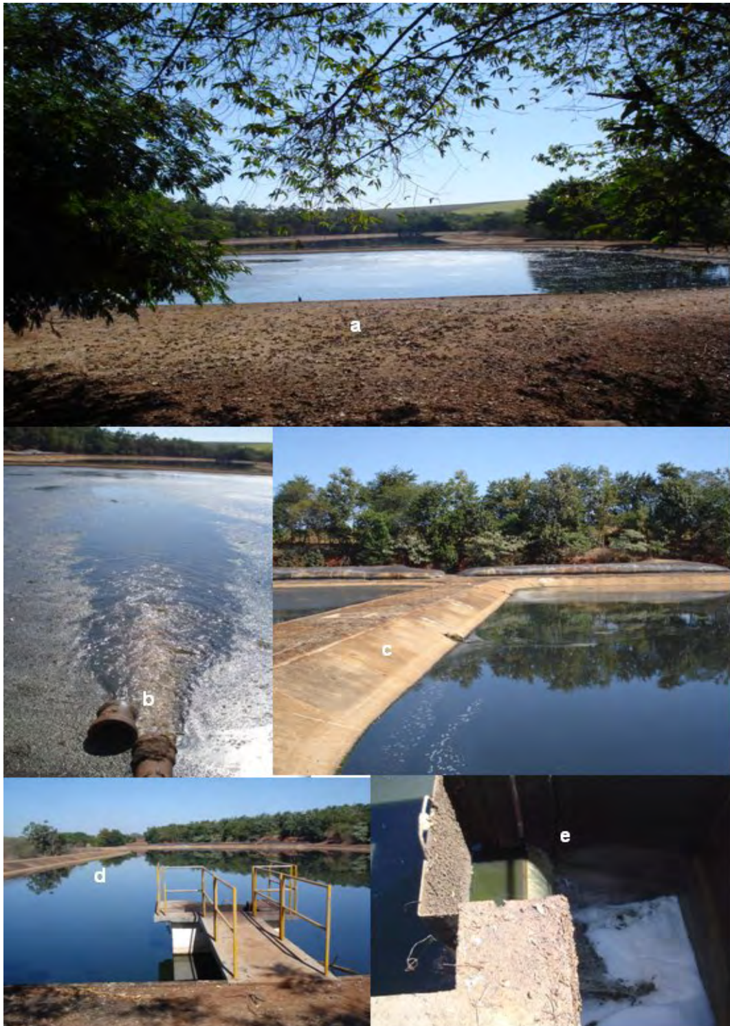
Figura 14 – Fotos da ETE de Areiópolis. a-b-c-d) Imagens da ETE - lagoa de estabilização e chegada do esgoto bruto; e) Saída do esgoto tratado.
