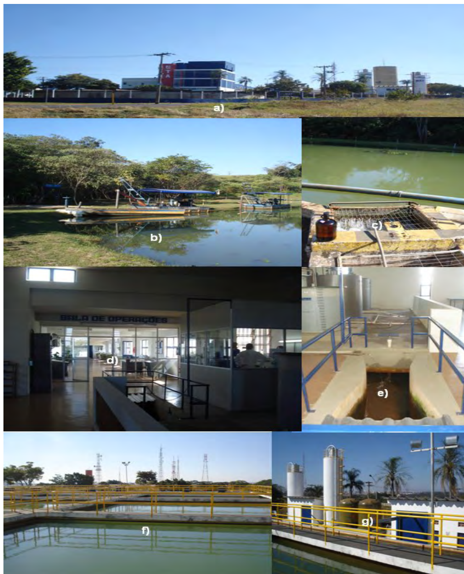
Figura 15 - Fotos ETA Bauru, onde as fotos: a) vista de frente da ETA, b - c) fotos do ponto de captação, d) laboratório da ETA, e - f - g) processo de tratamento da água na ETA.
