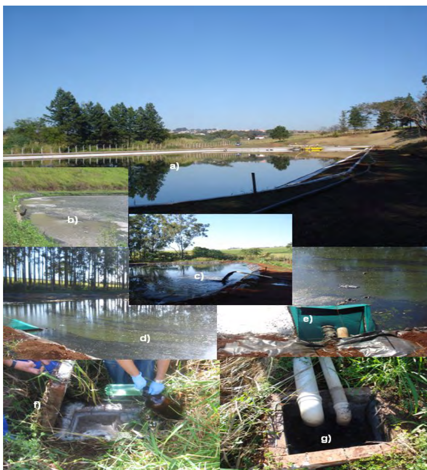
Figura 17 - Fotos da ETE de Bocaina. a - b) Vistas das lagoas; c) Características do esgoto no período de manutenção na ETE – dragagem com retirada do lodo; d) Aspecto do esgoto tratado; e) Lagoa auxiliar para remoção do lodo sem impermeabilização adequada; f – g) Caixas de coleta de esgoto tratado.
