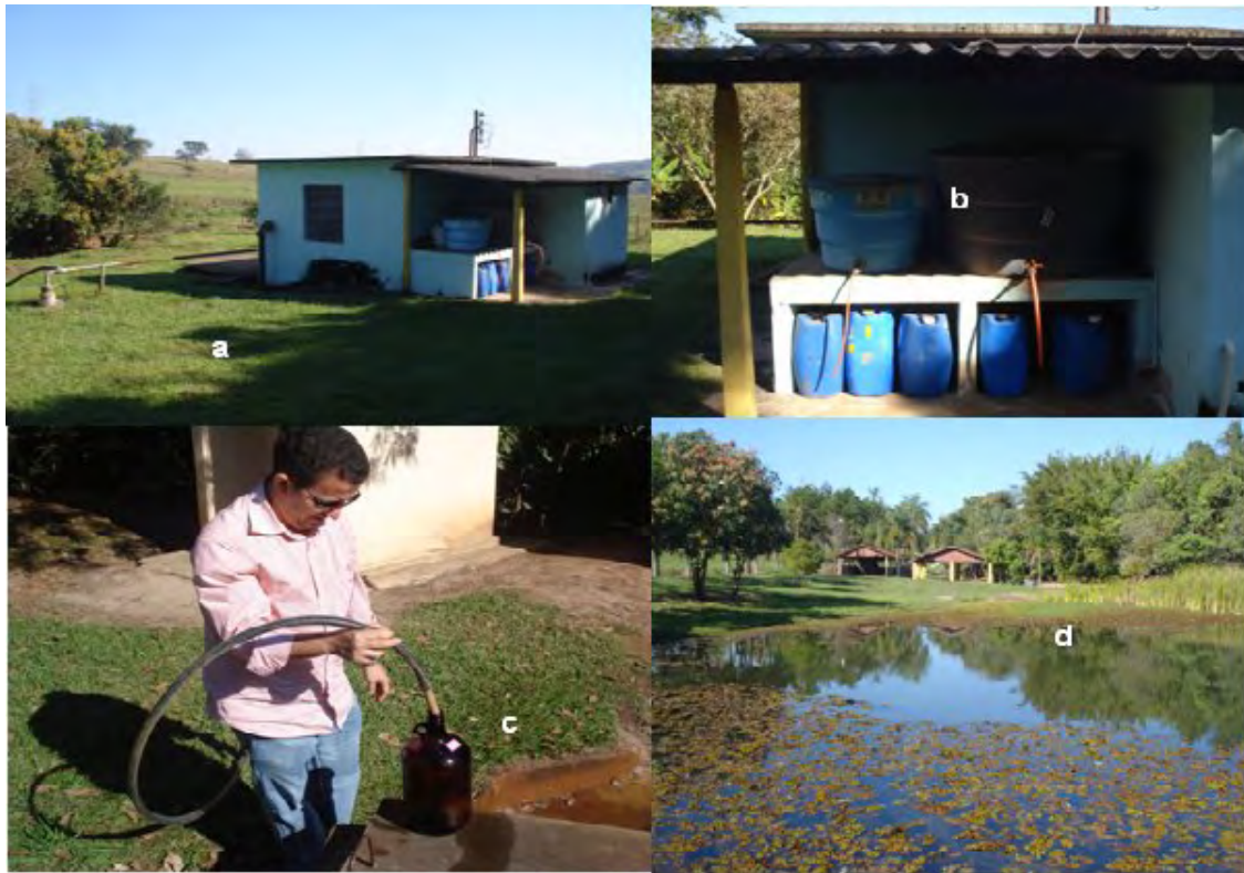
Figura 20 - ETA Itaju , onde as fotos a - b) apresentam a estrutura e processo de tratamento (desinfecção da água) da ETA, c) coleta da água bruta – água de mina, d) água represada na ETA.
