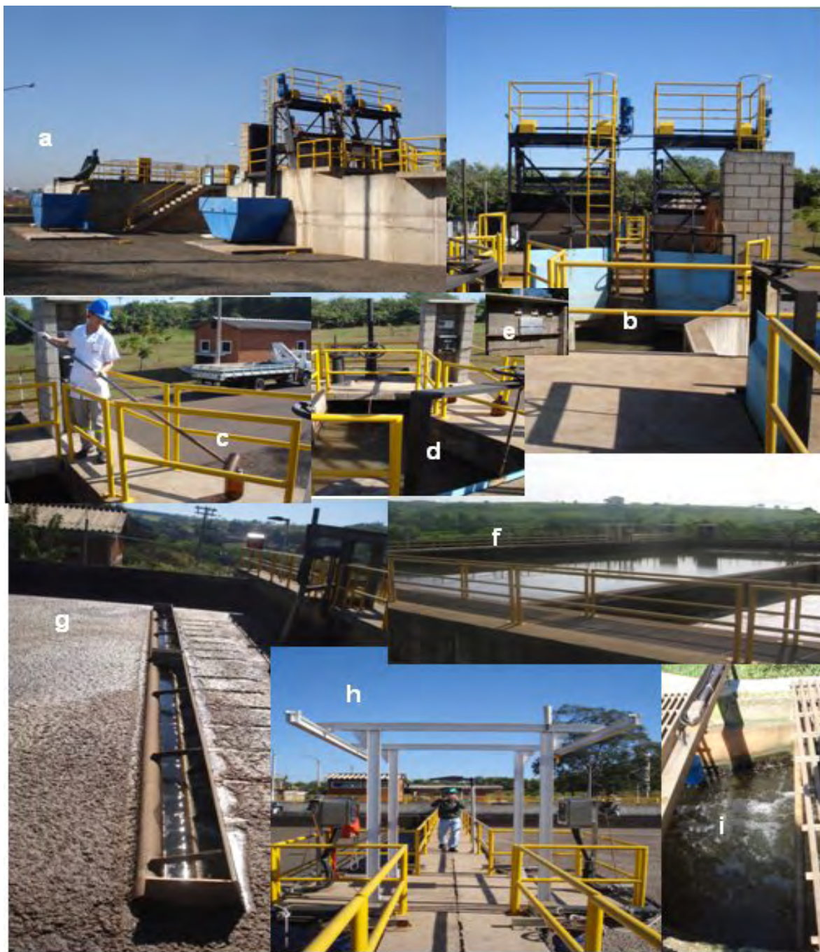
Figura 22 - Fotos da ETE de Jaú. a – b – c – d) Fotos da entrada do esgoto bruto: sistema de gradeamento, calha Parchal e coleta da amostra; e) Amostrador automático; f – g - h) Imagens dos tanques de decantação, aeriação; i) Ponto de coleta do esgoto tratado.
