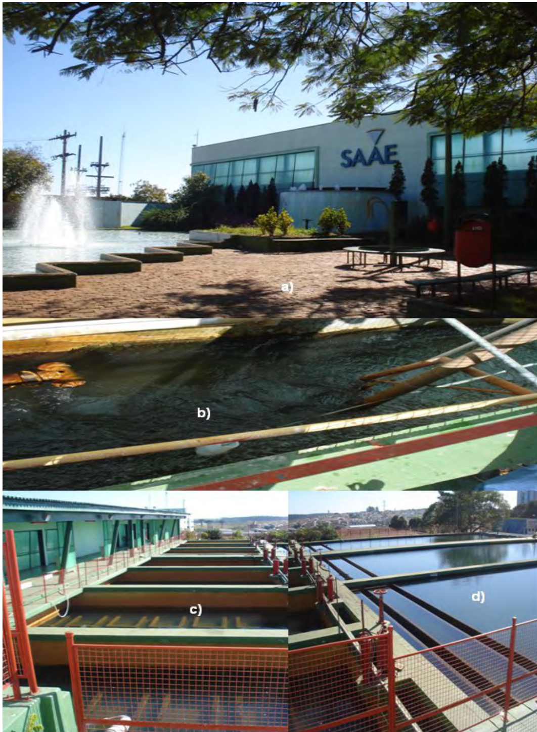
Figura 26 - Fotos ETA São Carlos , fotos: a) vista da ETA, b) entrada da água bruta, c – d) processos de tratamento da ETA.
