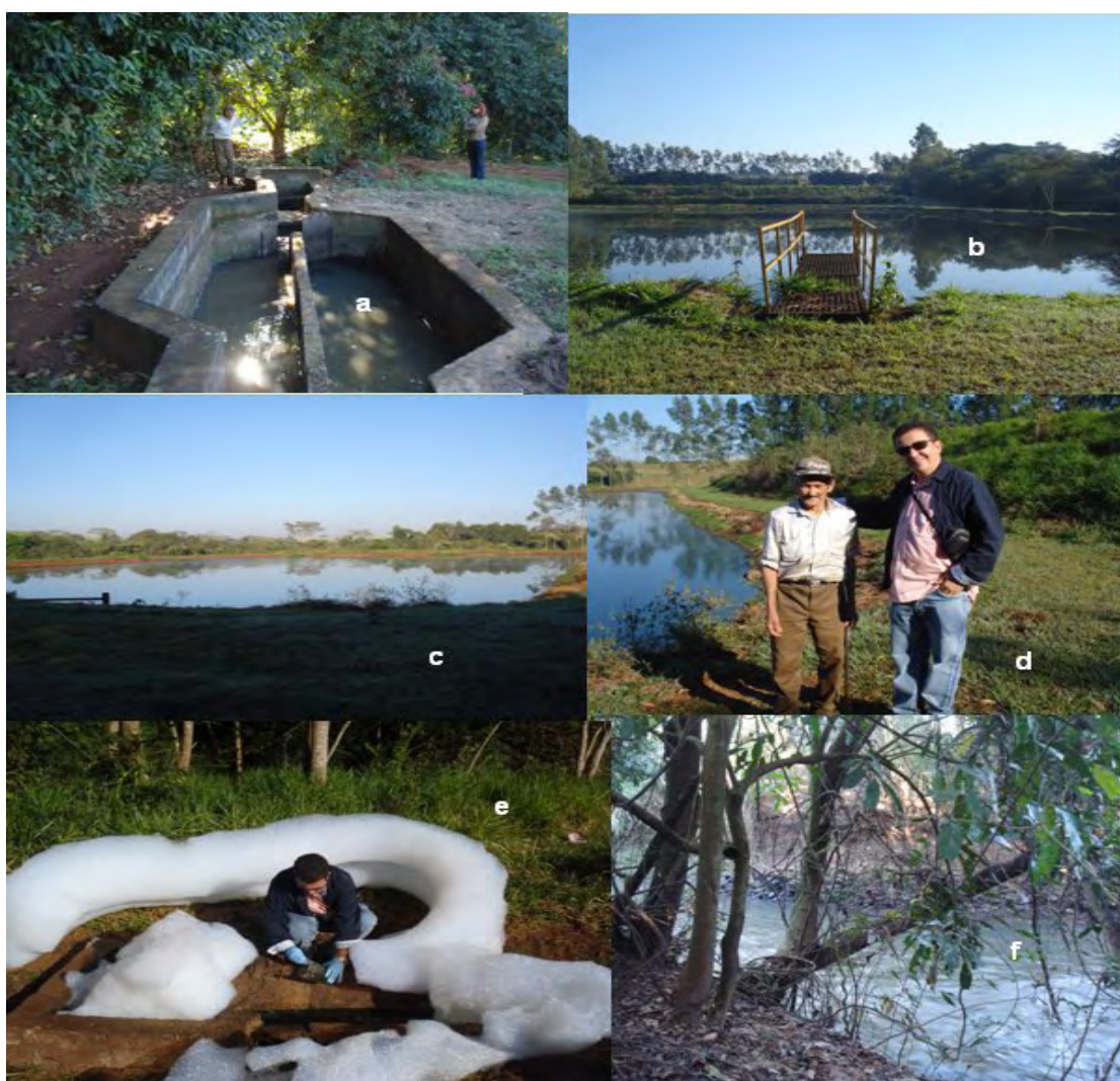
Figura 25 – Fotos da ETE Nova Europa. a) Chegada do esgoto bruto na calha Parshal; b - c) Lagoas de estabilização anaeróbias e facultativas; d) Foto do operador da ETE; e) Ponto de coleta do esgoto tratado – grande quantidade de detergentes; f) Foto do rio que recebe o efluente da ETE.
