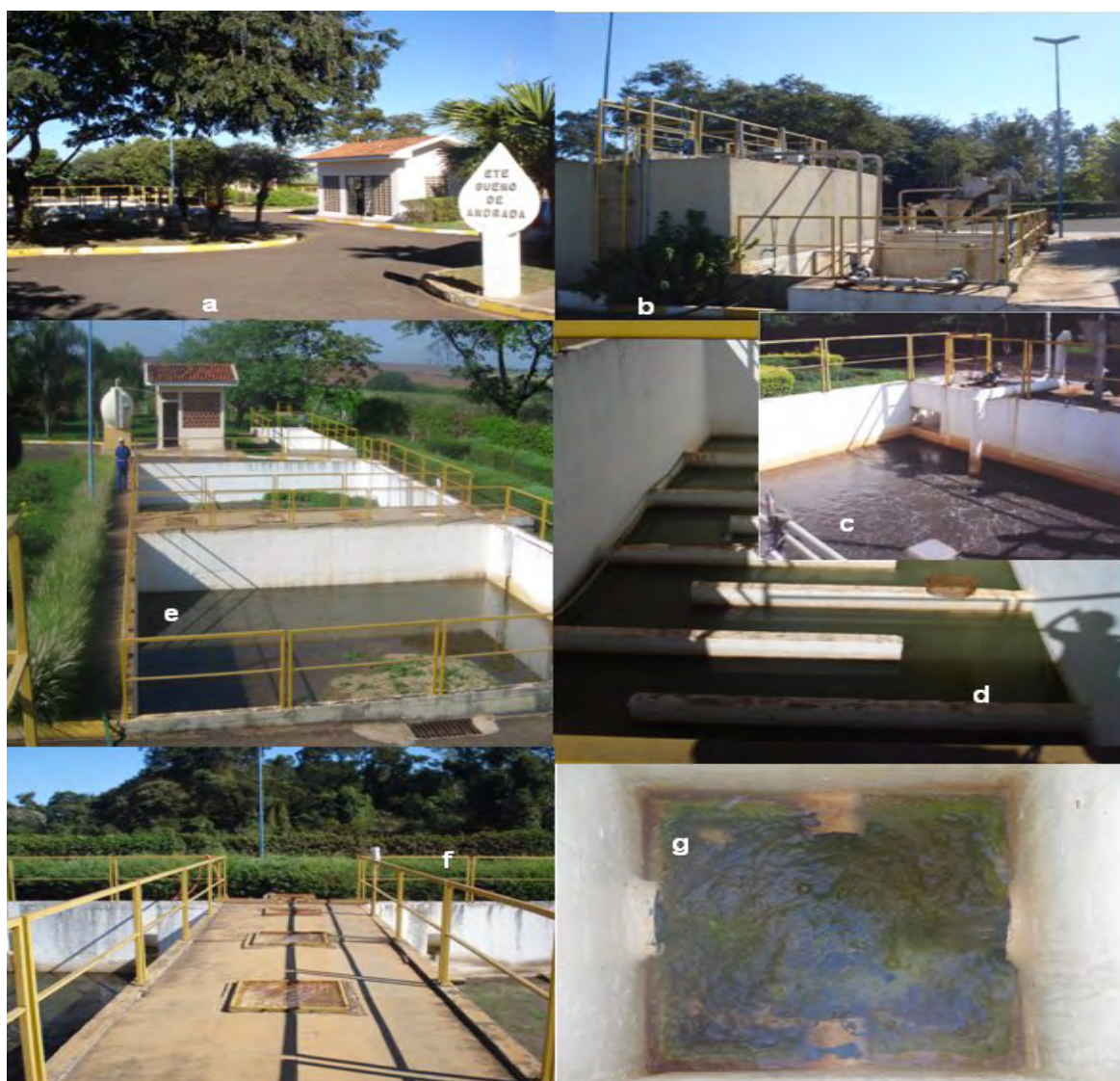
Figura 19 – Fotos da ETE de Bueno de Andrada. a) Foto da entrada da ETE; b) Vista do Rotamat e Reatores aeróbios (seqüência de reatores em batelada); c) Tanque de armazenamento e homogeneização (TAR - tanque de armazenamento de resíduo); d) Câmara de desinfecção onde é adicionado hipoclorito de sódio; e) Filtro de areia; f) Saída do esgoto tratado; g) Ponto de coleta do esgoto tratado.
