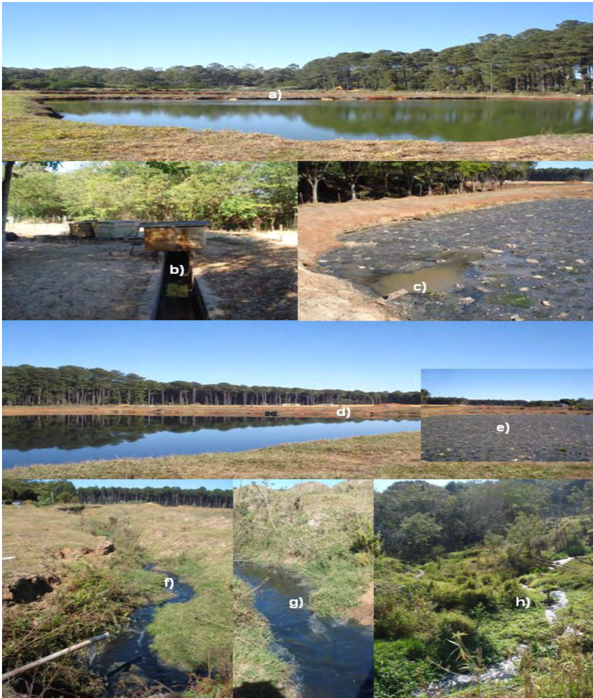
Figura 21 - Fotos da ETE Itirapina , onde as fotos: a – d) apresentam vista das lagoas, b) calha de entrada do esgoto bruto e caixas de chorume, c - e) característica da lagoa anaeróbia, f – g – h) esgoto tratado, efluente chegando ao manancial receptor.
