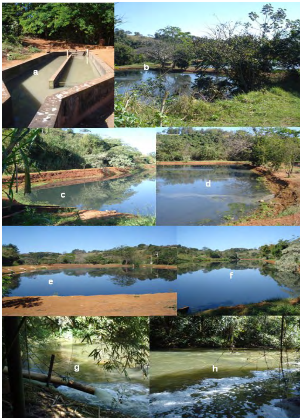
Figura 18 - Fotos ETE Brotas , onde as fotos: a) ilustra a entrada do esgoto na ETE através da calha Parchal, b – c - d - e – f) fotos onde é percebida a ausência de revestimento das lagoas, e g – h), o ponto de lançamento no rio.
