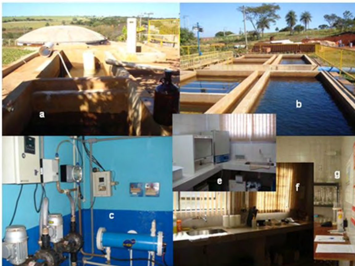
Figura 19 - Fotos ETA Brotas, fotos: a – b – c) chegada da água na ETA e etapas do tratamento e fotos e – f – g) apresentam o laboratório de análises físico-químicas e microbiológicas.
