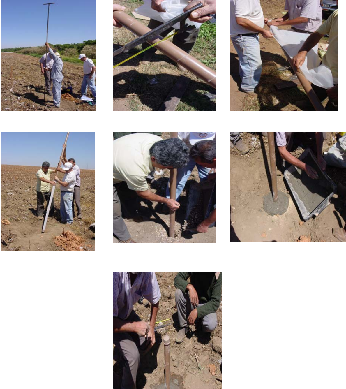
Figura 4 - Instalação do poço de monitoramento.
