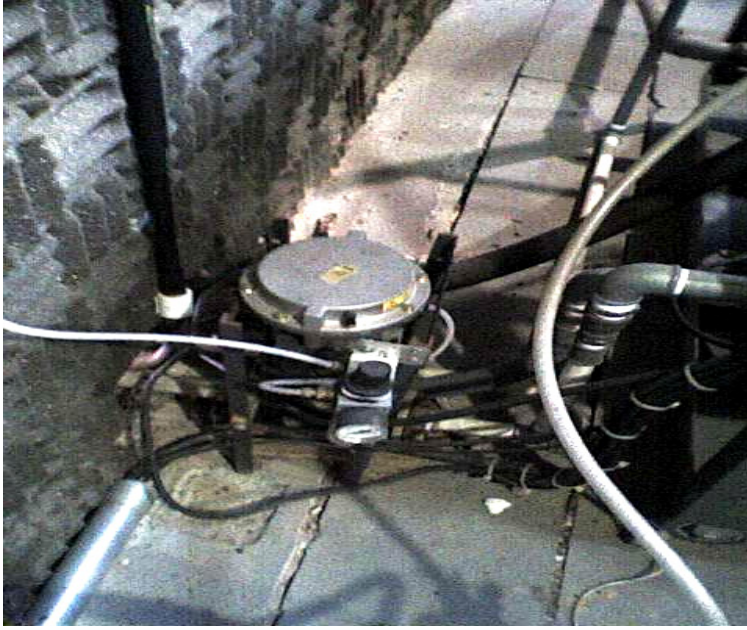
Figura 40 Válvula termostática controladora do fluxo da água de refrigeração
