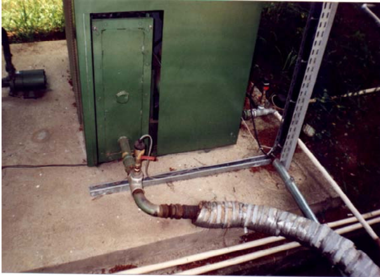
Figura 39 Máquina de absorção acionada pelos gases de escape
