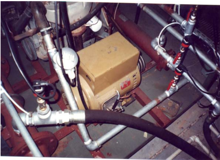
Figura 36 Gerador elétrico ligado ao motor de combustão interna
