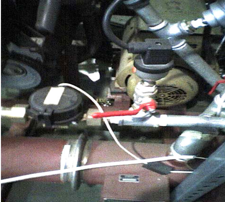
Figura 42 – Medidores de pressão, vazão e temperatura instalados
