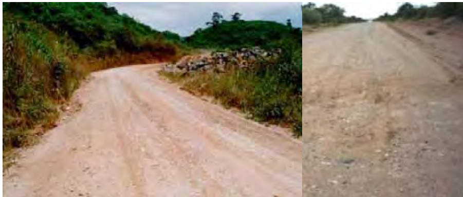
Figura 16 – Exemplos de estradas de terra em boas condições.
