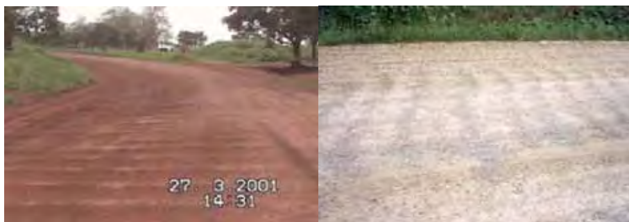
Figura 19 – Exemplos de estradas de terra com “costelas de vaca”.
