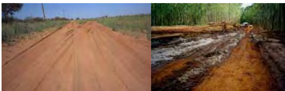
Figura 20 – Exemplos de estradas de areia / argila prensada.
