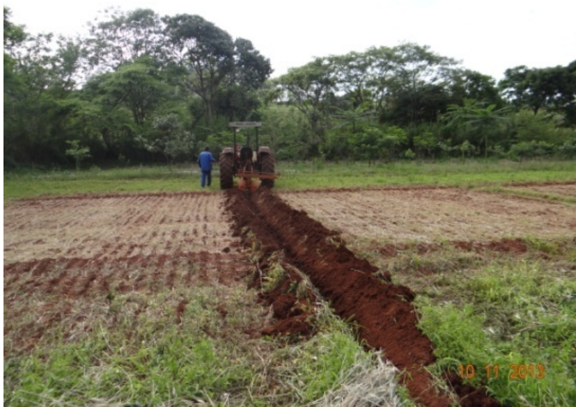
Figura 11- Construção de drenos entre tabuleiros (Fonte: AUTOR).
