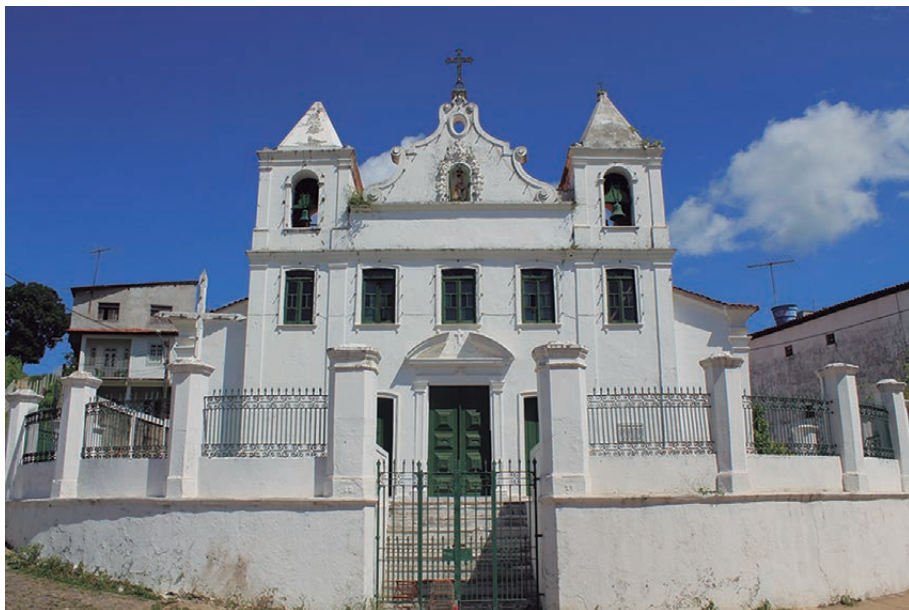
Figura 93 – Igreja de Santo Amaro da Purificação, região do Recôncavo, baía de Todos os Santos (BA). Foto: Rafael Schunk, 2010.
