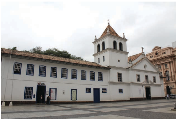
Figura 16 – Fachada do Pátio do Colégio, templo erguido sobre as fundações da igreja original desabada em fins do século XIX. Foto: Rafael Schunk, 2011.
