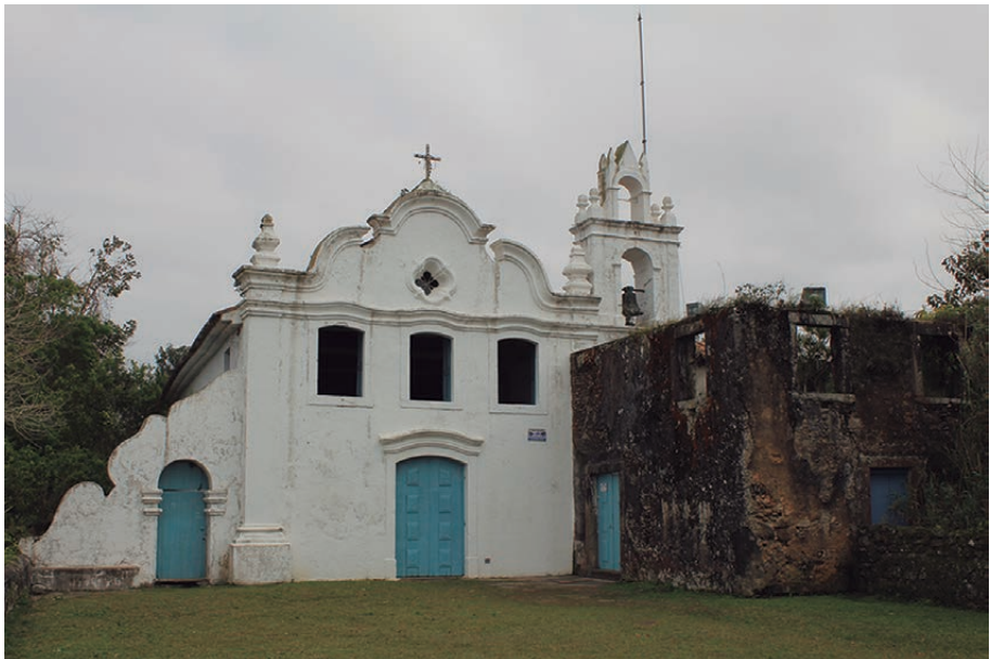
Figura 270 – Fachada da Igreja e Convento de Nossa Senhora da Conceição de Itanhaém (SP). Provável disposição adotada pelo Mosteiro de São Bento de Parnaíba (SP). Foto: Rafael Schunk, 2010.
