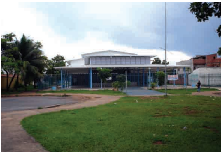
Figura 47 – Quadra 106 Sul, rua interna, praça e igrejas. Fotografia tomada em 12 de janeiro de 2007.
