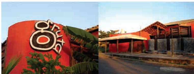
Figura 22 – Bar localizado numa esquina na Quadra 103 Sul. Fotografia tomada em julho de 2007.
