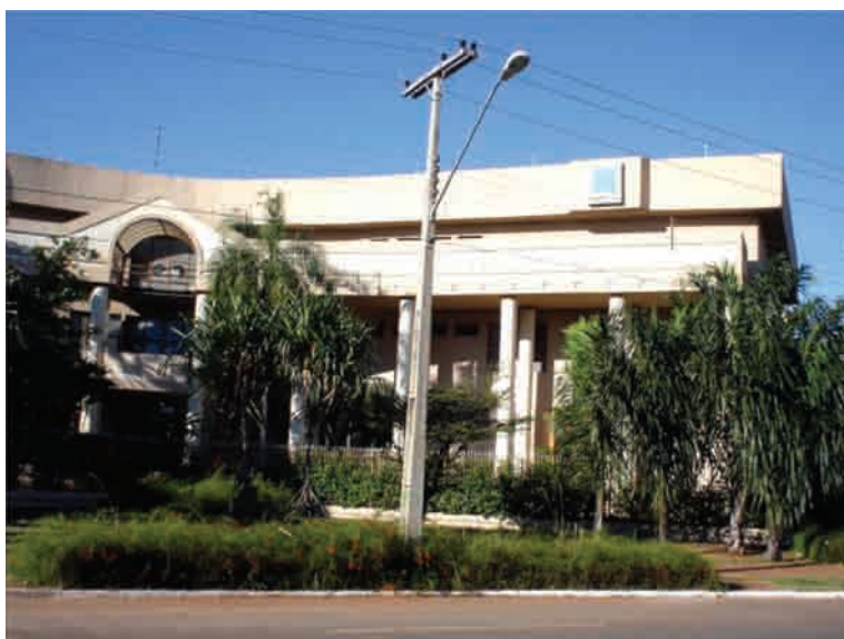
Figura 25 – Edifício do Colégio Marista em Palmas. Fotografia tomada em setembro de 2006.
