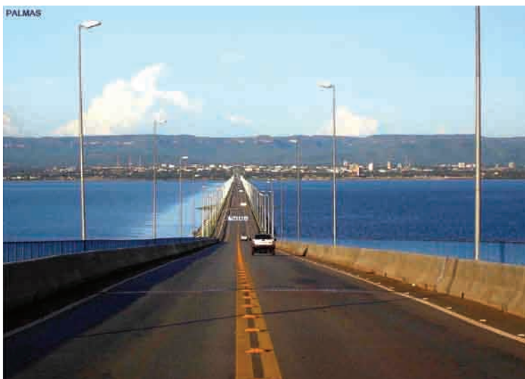
Figura 57 – Ponte FHC (Palmas - TO). Fotografia de Thenes Pinto, 2007.
