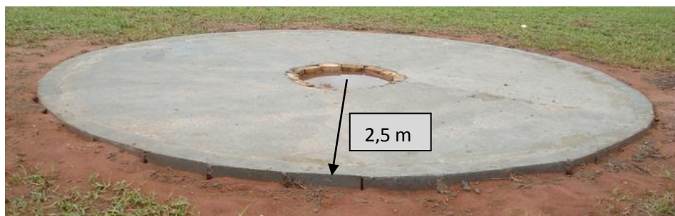
Figura 15 – Base do Marcador de Tempo do Sol finalizada. Fonte: Elaborado pela autora (2013).
