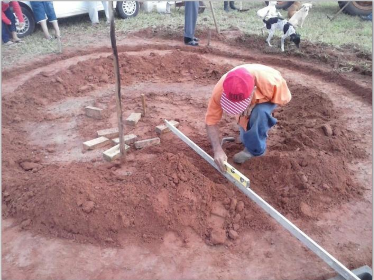
Figura 13 – Nivelamento do terreno para a construção do Marcador de Tempo do Sol. Fonte: Elaborado pela autora (2013).
