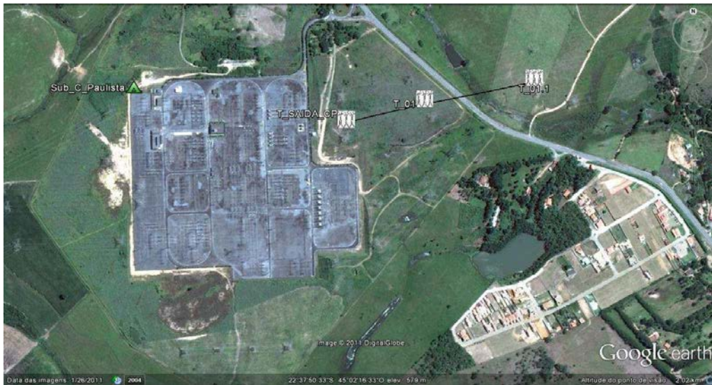
Figura 4 - Subestação do Bairro do Embaú município de Cachoeira Paulista –SP
