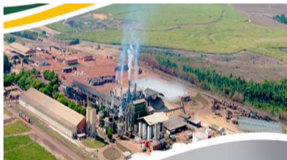
Figura 5 - Usina Sucroalcooleira Barralcool de Barra do Bugres - MT.
