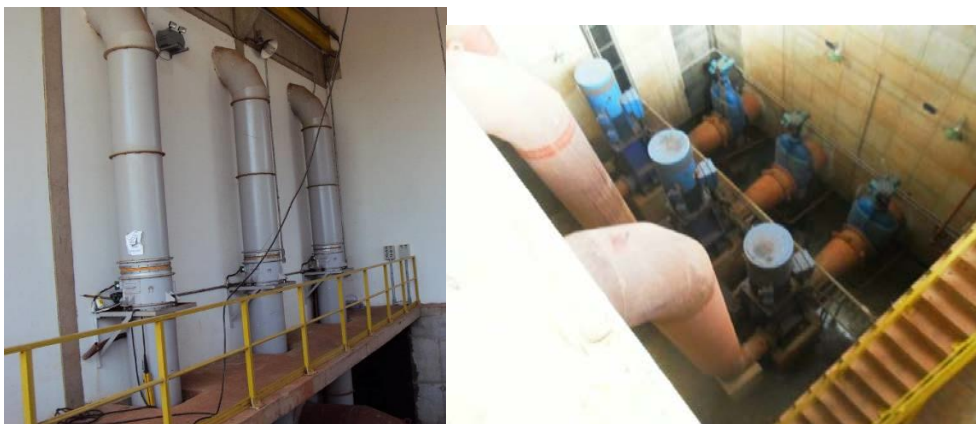
Figura 2.7- Estação Elevatória de esgoto bruto
