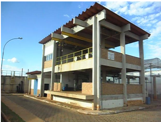
2.16 a) Estação Elevatória de Lodo
