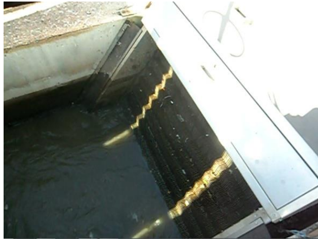
Figura 2.8 - Gradeamento fino
