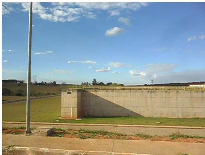
Figura 2.13 - Tanque de Aeração
