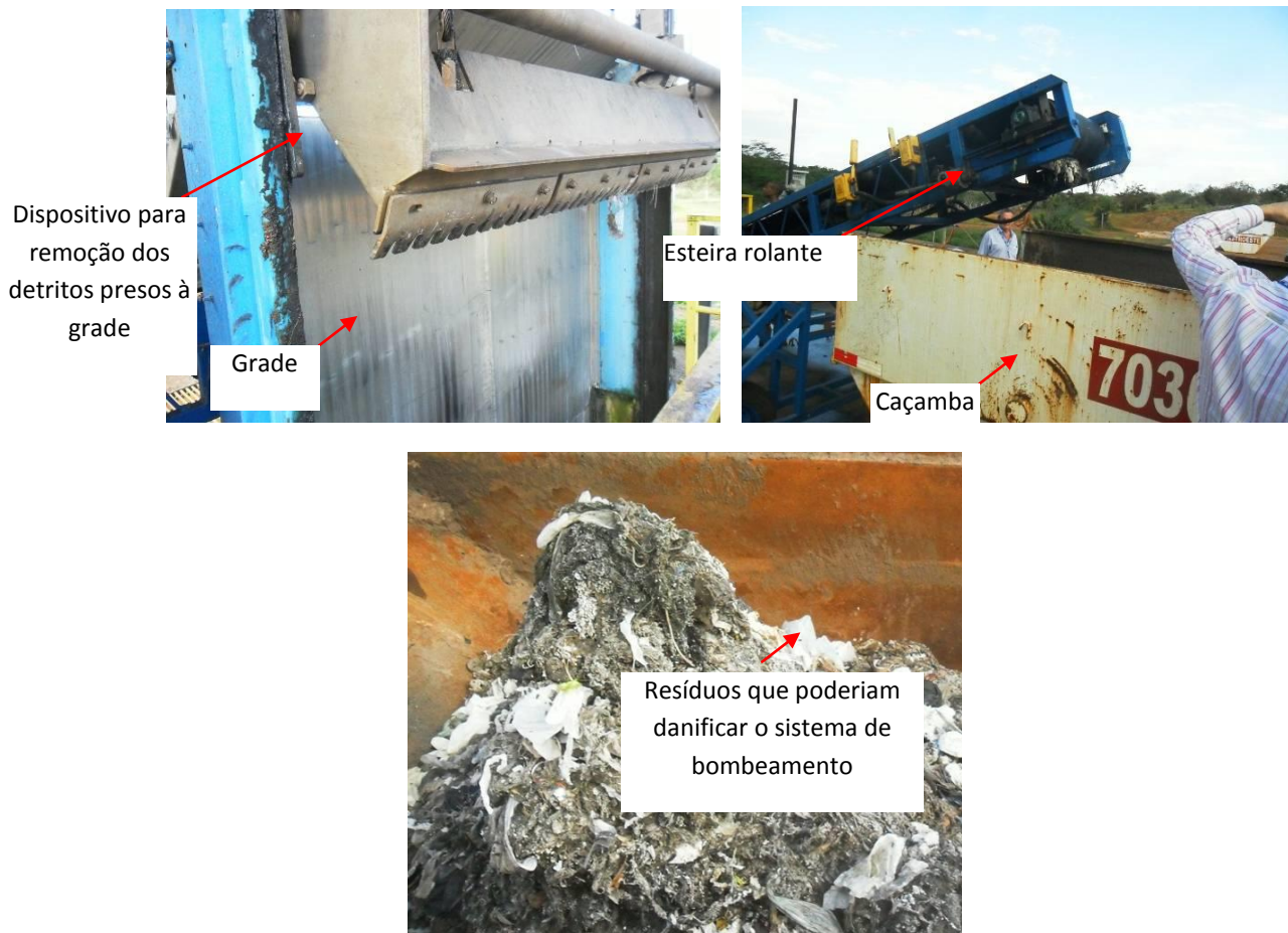
Figura 2.6 – Dispositivos usados no procedimento de remoção de sólidos grosseiros
