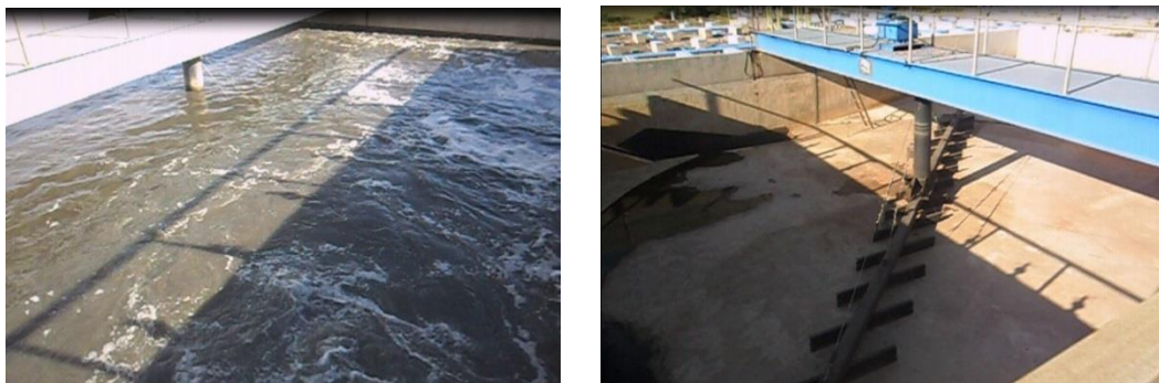
Figura 2.10 – Desarenadores: cheio e vazio
