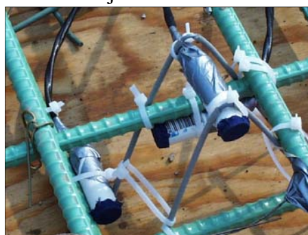
Figura 68- Sensor instalado junto à armadura antes da concretagem.
