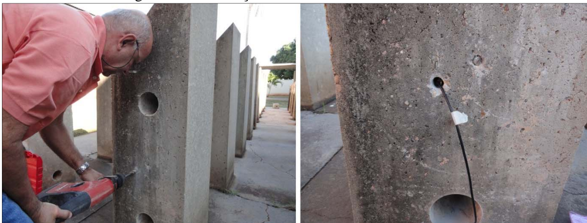
Figura 89- Verificação da umidade interna no concreto.
