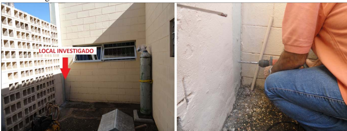
Figura 90- Pilar do LCEC onde foi medida a umidade interna no concreto.
