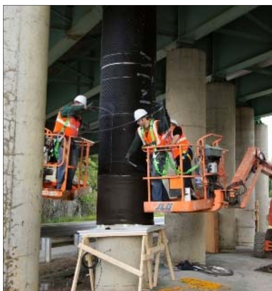
Figura 24- Aplicação do tratamento eletroquímico com nitrato de lítio utilizando malha de titânio.
