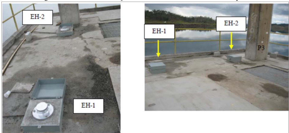
Figura 59- Local de instalação dos extensômetros de hastes múltiplas.
