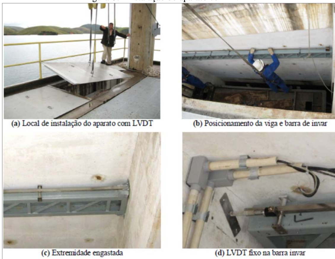
Figura 67- Instalação do aparato com LVDT.
