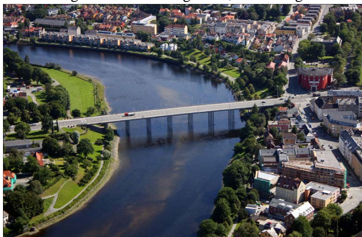
Figura 26- Ponte Elgeseter, na Noruega.
