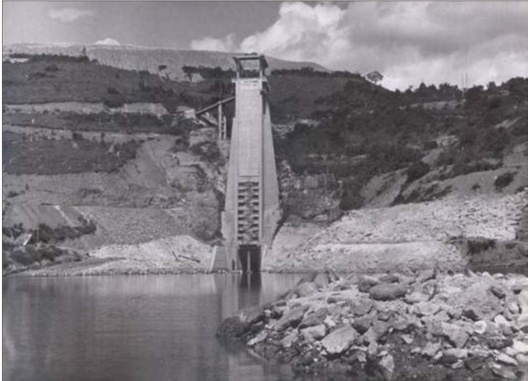
Figura 5- Estrutura da tomada d'água durante a construção da usina.
