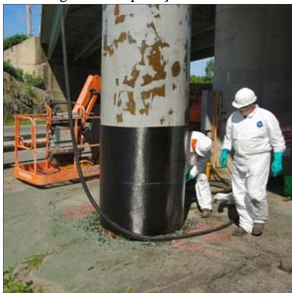
Figura 23- Aplicação do CFRP.
