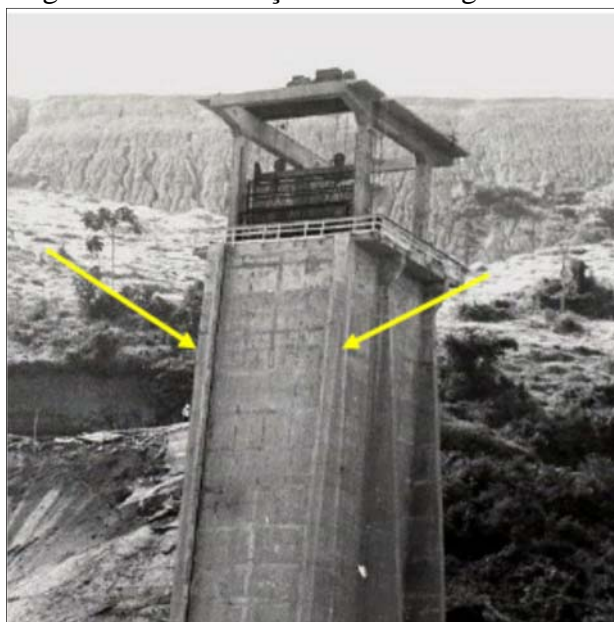
Figura 65- Localização dos muros guia na TA.
