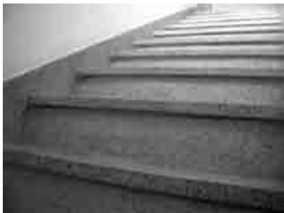
Figura 1 – Degraus da escada Foto do autor
