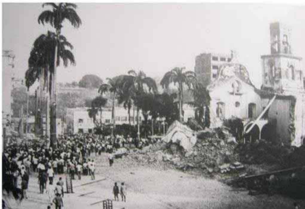
ILUSTRAÇÃO 47 – Demolição da igreja matriz de Cuiabá, 1968
