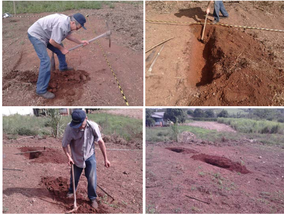
Figura 7.17: Abertura das valas de infiltração na Área 1.
