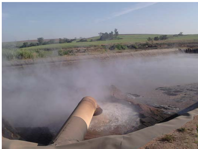
Figura 7.14: Vista da lagoa de armazenamento de vinhaça da Usina Granelli. É possível notar o tubo condutor por onde a vinhaça é trazida desde a usina e parte do revestimento impermeabilizante de PAD da lagoa.
