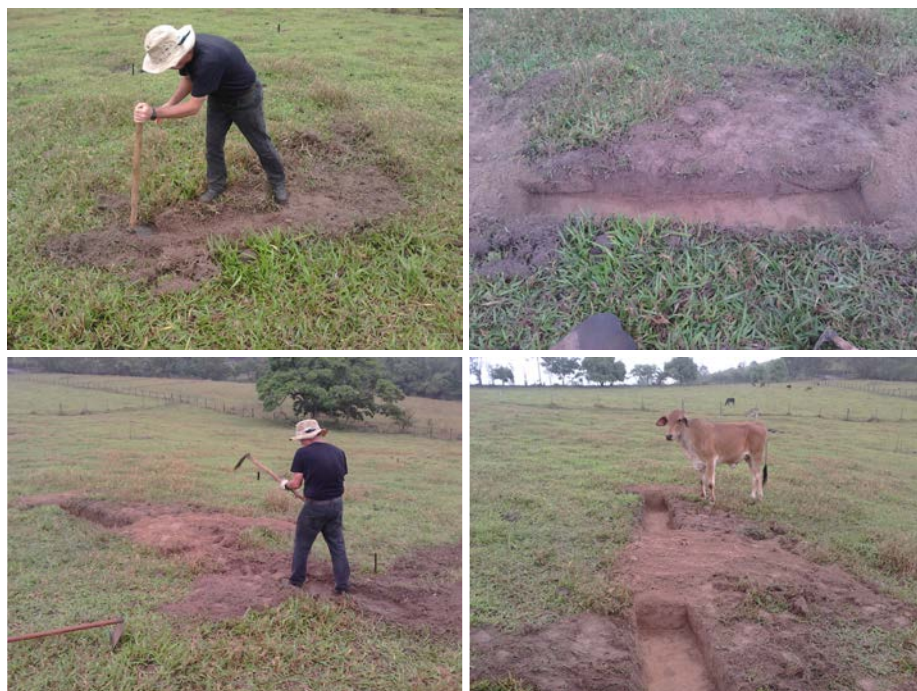
Figura 7.18: Abertura das valas de infiltração na Área 2.
