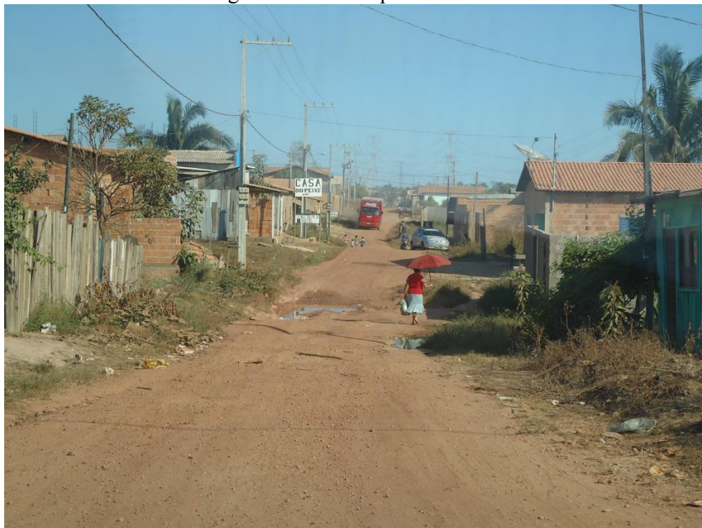
Figura 8: Vias não pavimentadas
