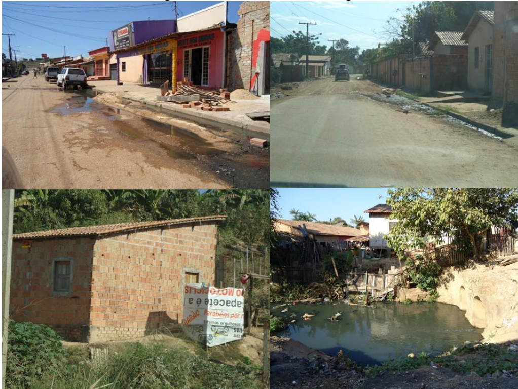
Figura 7: Falta de coleta de esgoto
