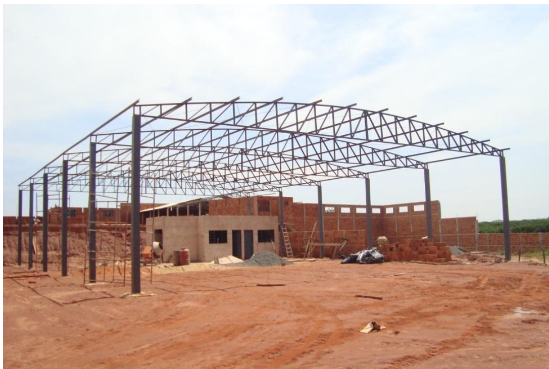
Figura 10. Sede física da APRA em construção.
