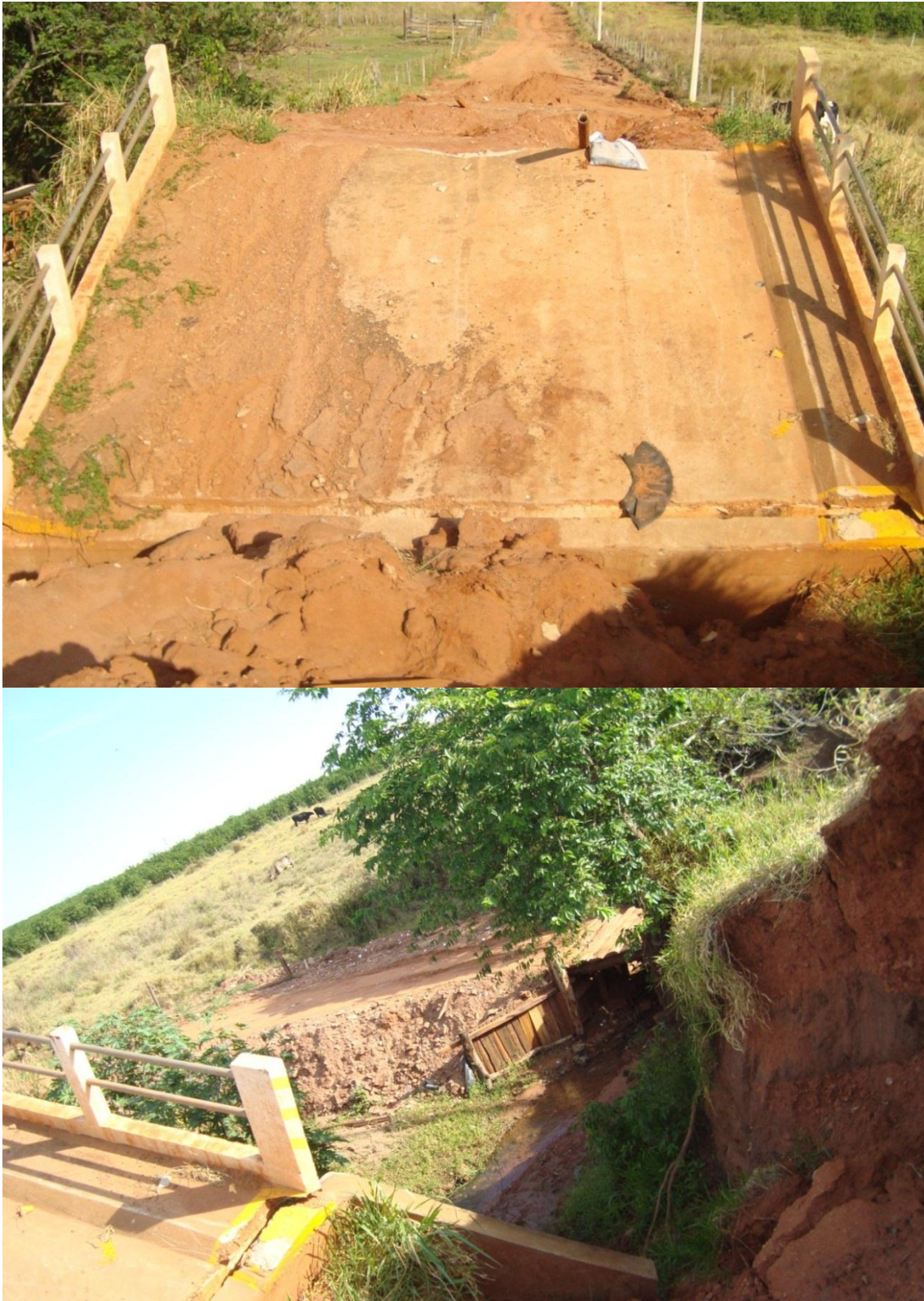
Figura 34. Ponte sem condições de tráfego em estrada rural no município de Urânia-SP. A ponte retratada na figura não foi reparada integralmente até o momento (2013) e evidencia a falta de ações e cuidados da maioria Prefeituras dos municípios do Território Rural do Noroeste Paulista com a área rural. Como medida paliativa, foi construído um pequeno aterro que não oferece condições de segurança para os veículos transitarem. Os maiores prejudicados são a população rural e os agricultores familiares.
