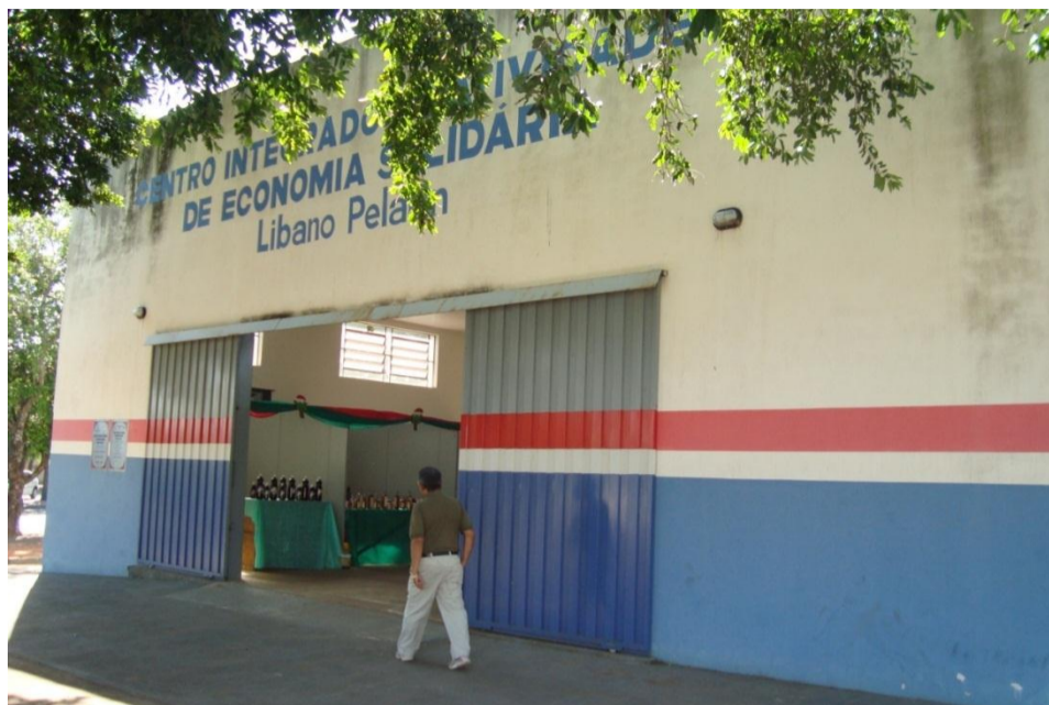
Figura 17. Fachada do Centro Integrado de Atividades de Economia Solidária da Região de Jales, projeto do PRONAT no TRNP.
