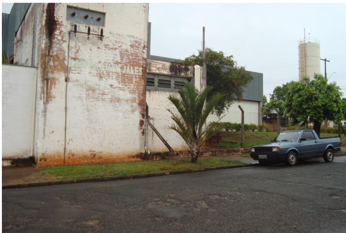
Figura 12. Fachada da CAMPRJ.
