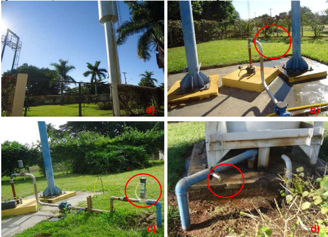
Figura 16 – Fotos dos pontos de coleta da ETA de Bueno de Andrada. a) ETA, b) ponto de coleta da água bruta e c) dosador automático d) ponto de coleta da água clorada.
