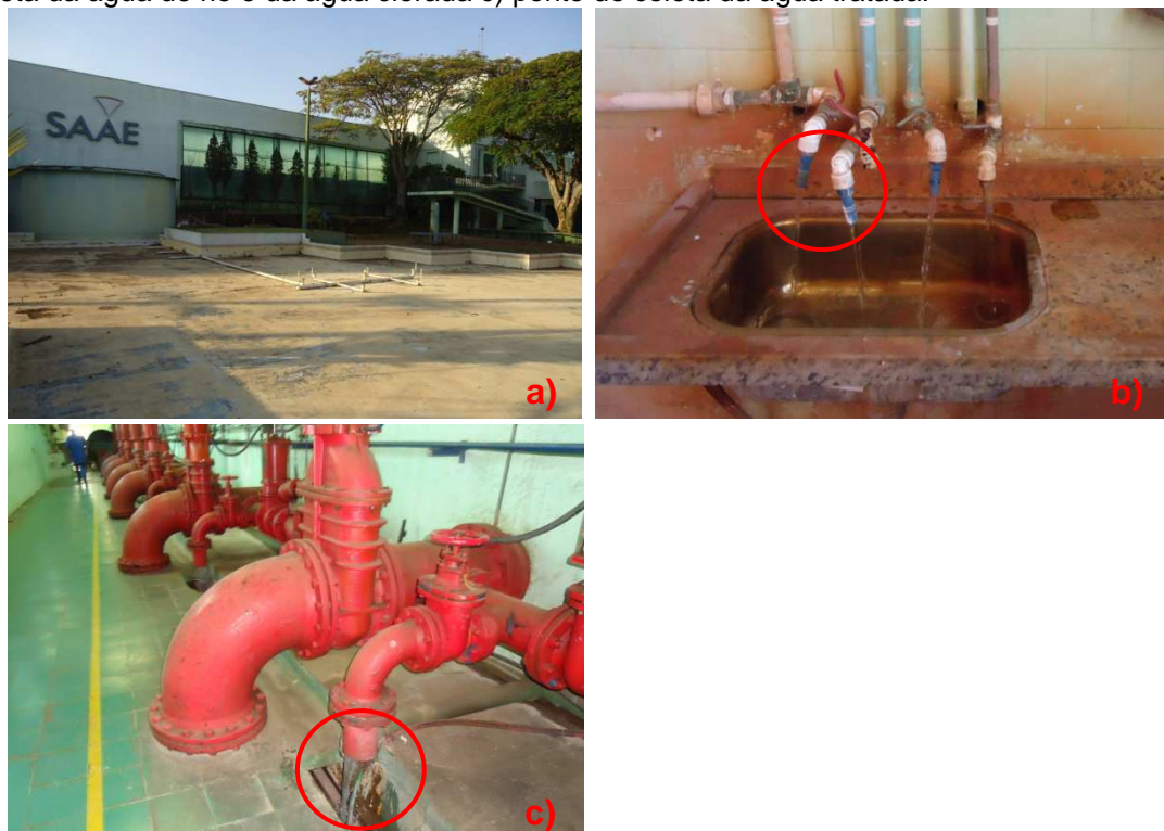
Figura 22 – Fotos dos pontos de coleta da ETA de São Carlos. a) foto da fachada da ETA b) ponto de coleta da água de rio e da água clorada c) ponto de coleta da água tratada.
