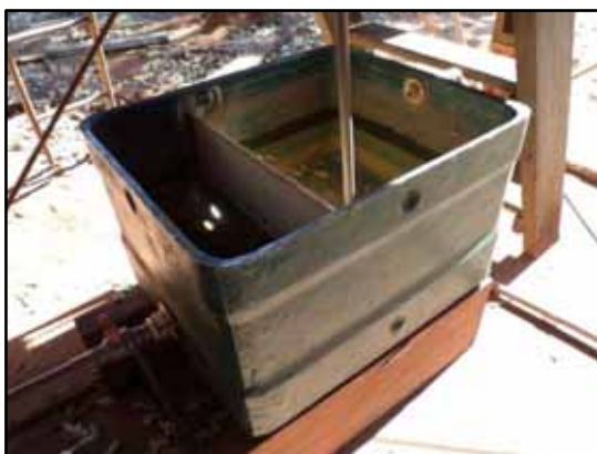
Figura 5 -Tanque de equalização
