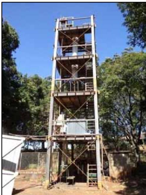
Figura 4 - Estrutura de suporte do sistema
