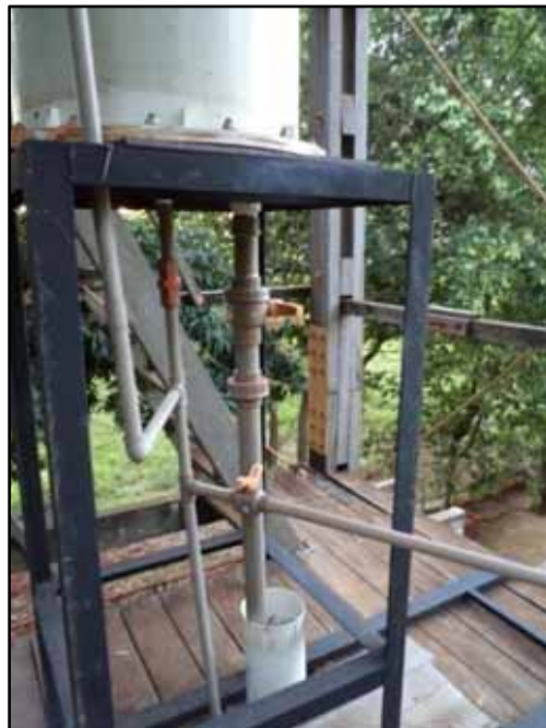
Figura 11 - Vista lateral inferior do reator
