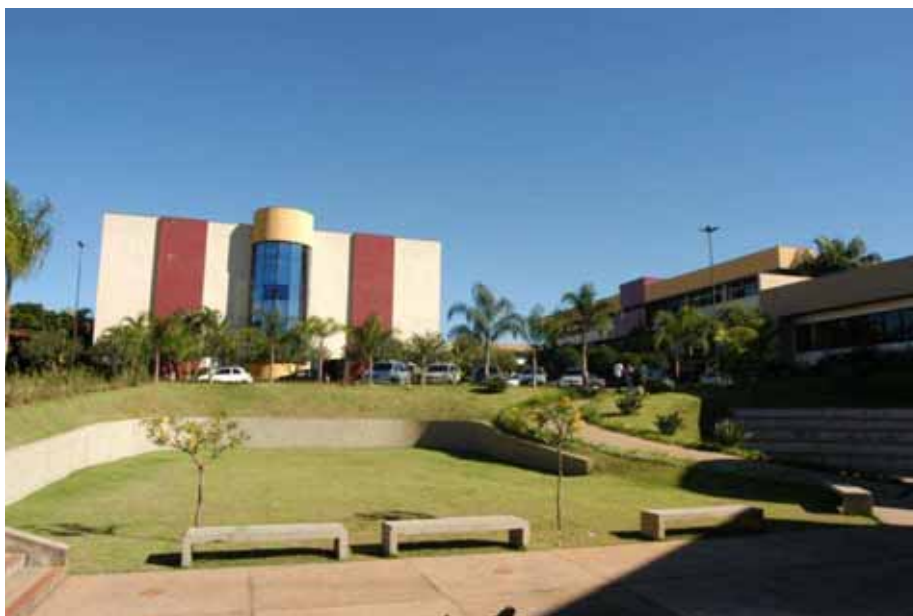
Figura 3 – Vista Parcial da Universidade de Franca (Bloco Bordô e Clínica de Odontologia)
