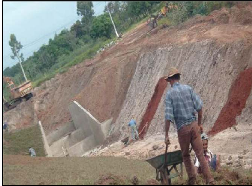
Figura 34 - Obras de contenção da erosão – Retificação do leito do córrego e canalização do esgoto
