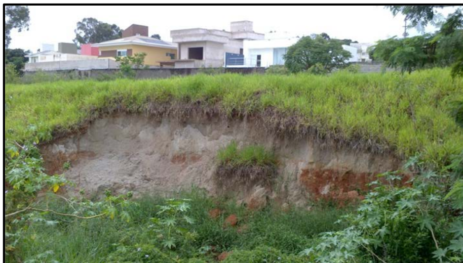
Figura 39 - Queda de talude à margem do córrego Água Comprida
