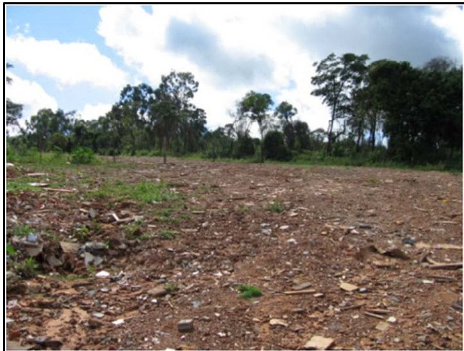
Figura 37 - Ramificação da erosão principal coberta com entulho e material orgânico
