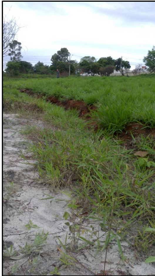
Figura 40 - Presença de sulcos à margem do córrego Água Comprida
