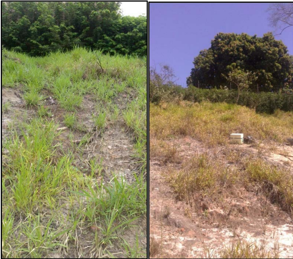
Figura 44 - - Detalhe dos locais escolhidos para coleta (retomada de processos erosivos com surgimento de sulcos)
