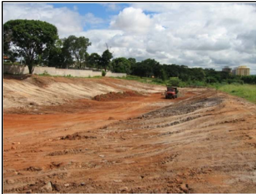
Figura 36 - Aterramento do afloramento de água
