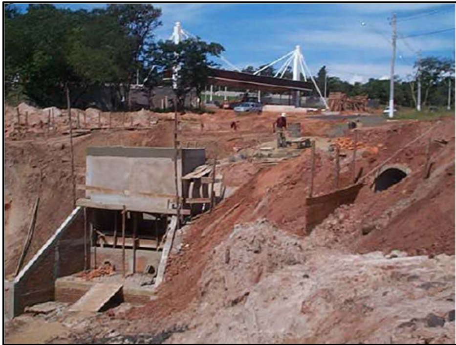
Figura 33 - Obras de contenção da erosão – Instalação de dissipadores de energia
