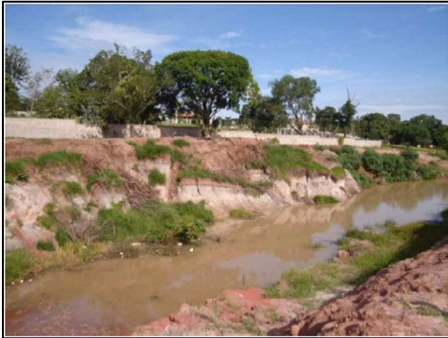
Figura 35 - Afloramento de água ao lado da erosão
