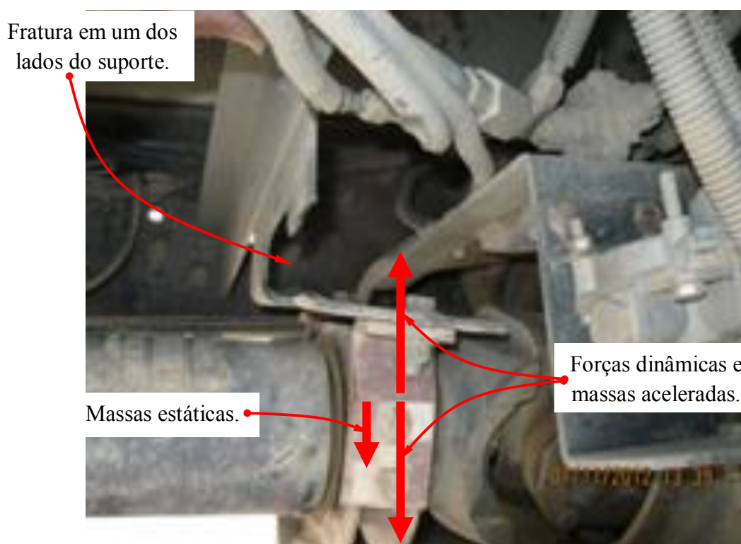
Figura 48 – Foto do suporte do mancal falhado.
