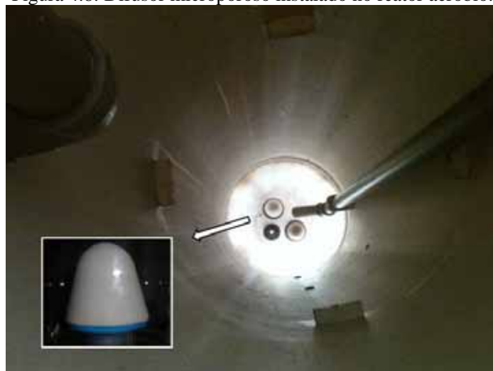
Figura 4.8: Difusor microporoso instalado no reator aeróbio.
