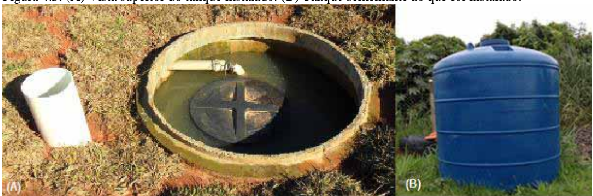
Figura 4.3: (A) Vista superior do tanque instalado. (B) Tanque semelhante ao que foi instalado.
