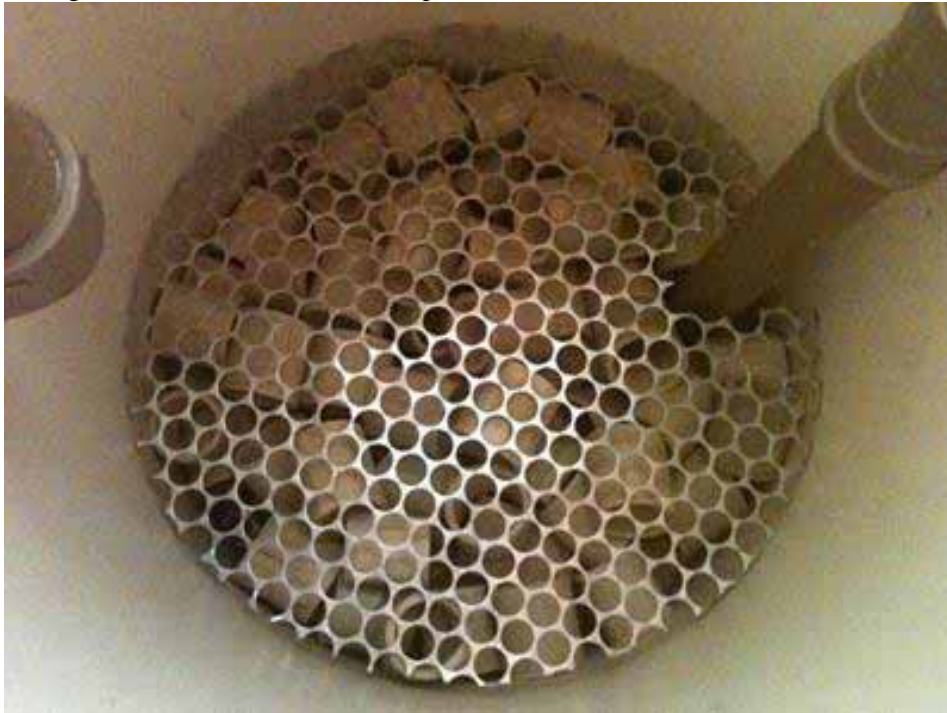
Figura 4.10: Anéis de bambu e suporte de metal, dentro da câmara aeróbia.
