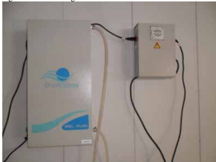
Figura 4.17: Sistema gerador de ozônio.
