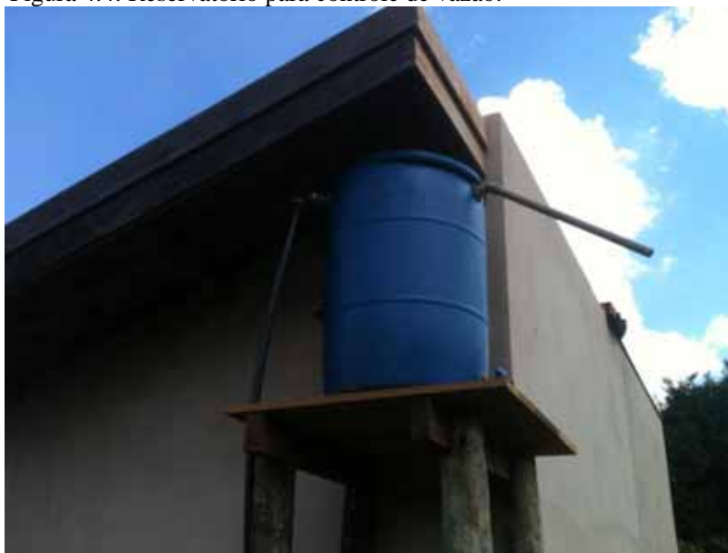
Figura 4.4: Reservatório para controle de vazão.
